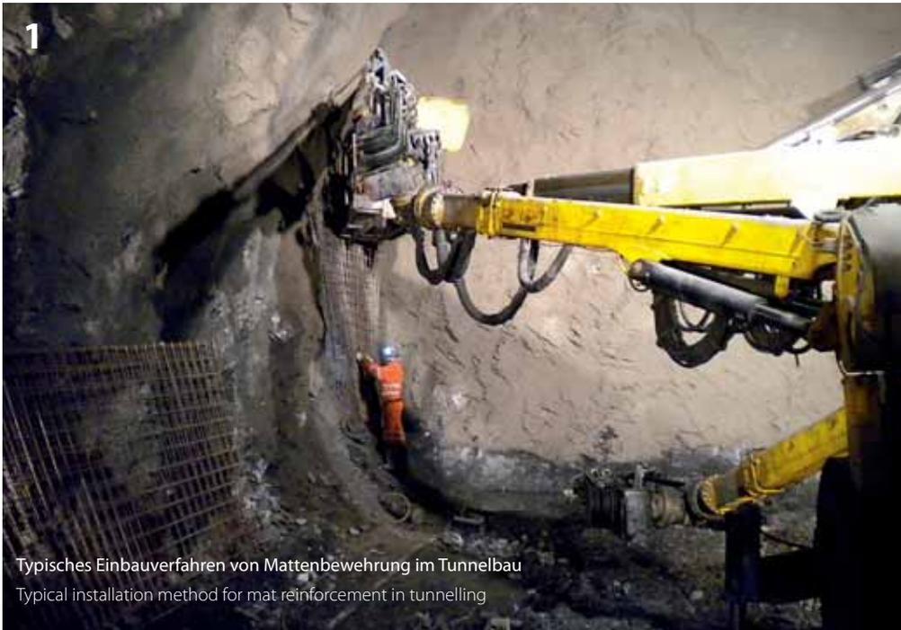
Typisches Einbauverfahren von Mattenbewehrung im Tunnelbau
