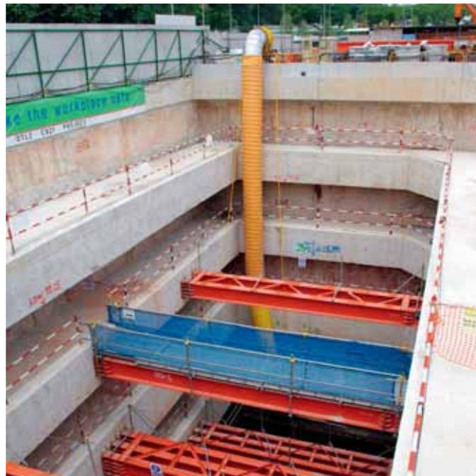
Blick in die Baugrube Richtung Sohle mit Aussteifungen gegen die Schlitzwände vom KPE Tunnel Singapur
