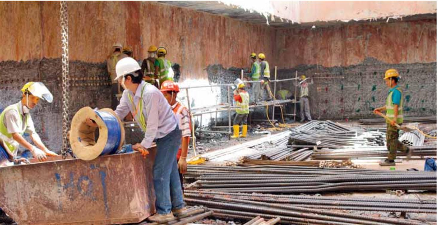
Verarbeitung des Injektionsschlauchs WaterproofX® 1 beim Tunnelabschnitt C921 der Downtown Line
