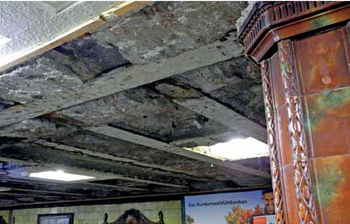
Freigelegte Träger, die Untersicht ist korrodiert, die Deckenträger lagern auf dem Unterflansch des Mittelträgers
