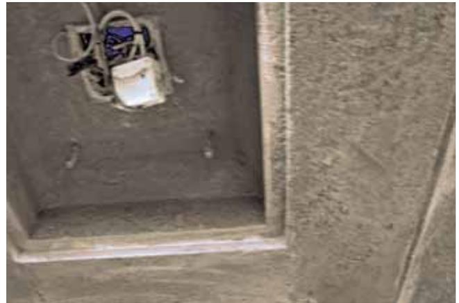
Fertig gestelltes Kassettenfeld: die Maße entsprechen dem Originalbestand, damit die Einbauleuchten, die nach der Renovierung wieder in die Kassettenfelder eingesetzt werden sollen, passen
