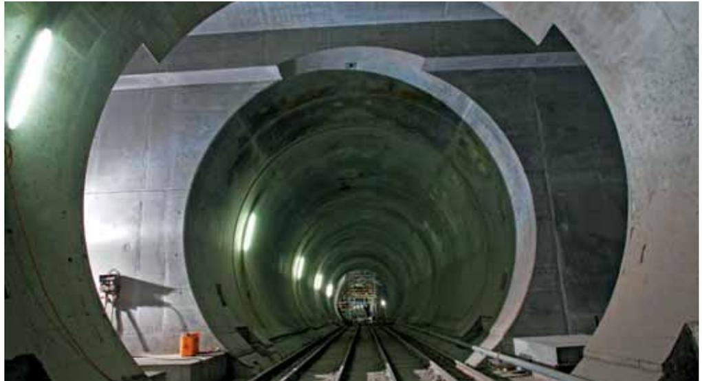
Gotthard-Basistunnel: Nische zum Einbau eines Spurwechsellators, TA Faido
