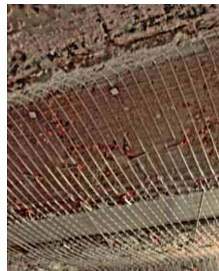
Freigelegter Deckenträger, mit Korrosionsschutz versehen und fertig gestellter Bewehrung
