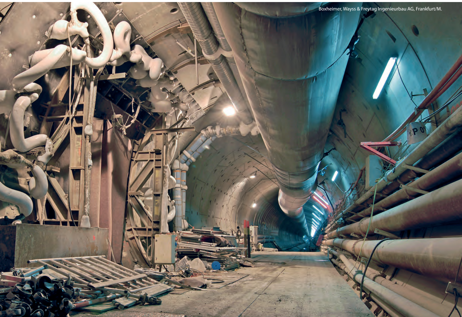
Tunnelröhre von Bild 3 im Bereich eines Querschlags (Bodenvereisung)
