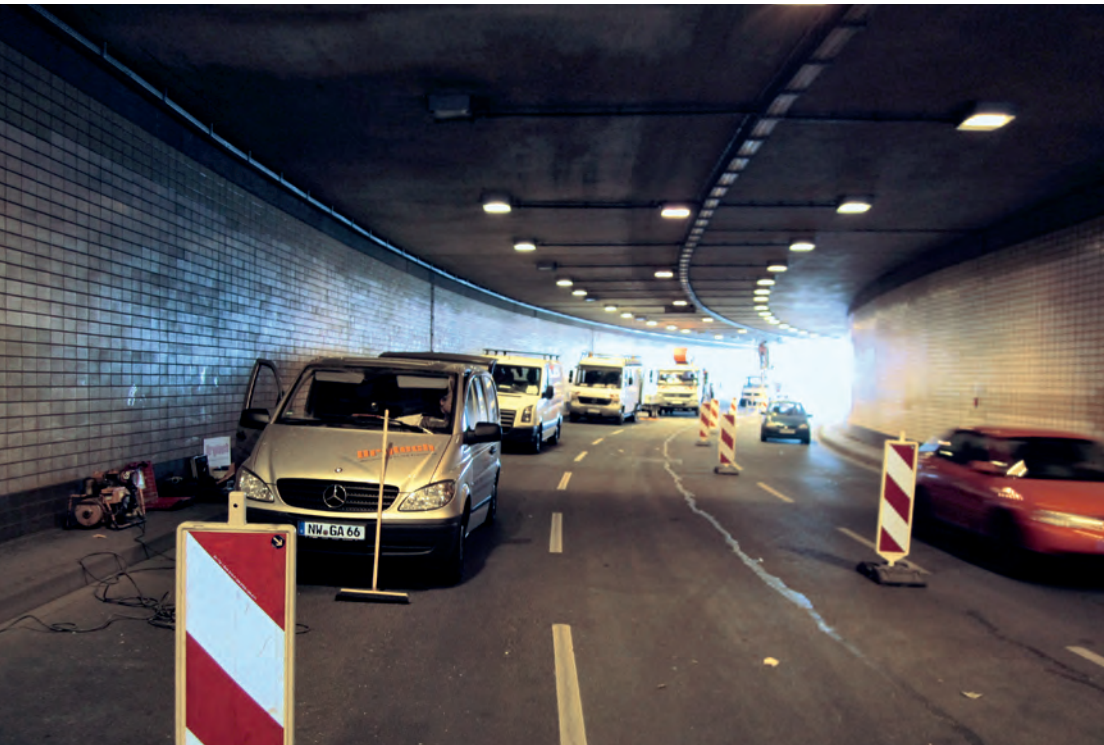
Für die 14-tägigen Sanierungsarbeiten wurden jeweils 2 der 3 Fahrbahnen gesperrt Two of the 3 lanes were closed during the fortnight-long redevelopment work
