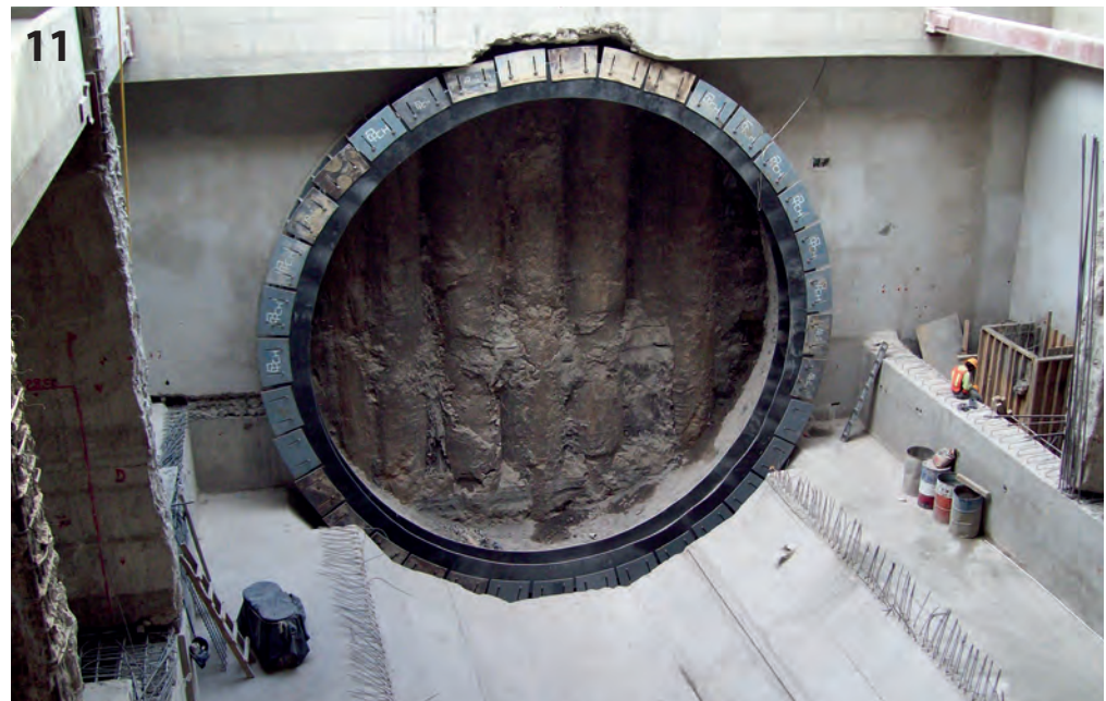
Parque de los Venados: Fenster zum Durchbruch der TBM durch die Schlitzwand
