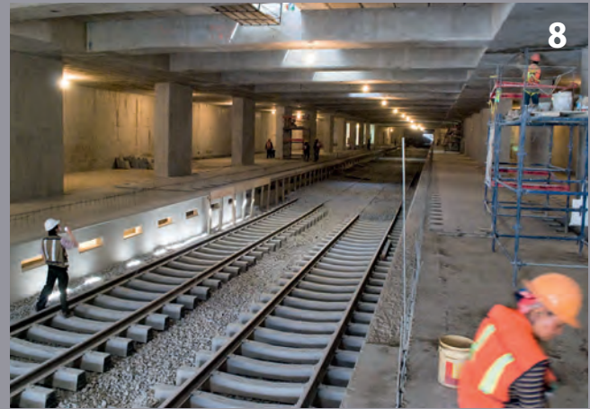
Die Station Atlalilco, eine der 20 Stationen der Metro Line 12 The Atlalilco Station, one of the 20 on Metro Line 12
