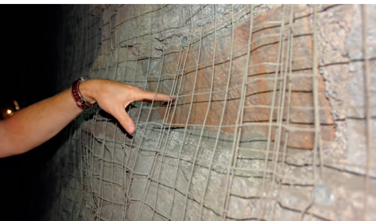
Befestigte Stahlnetze vor Einbau des Spritzmörtels Mounted steel nets prior to placing the sprayed mortar
