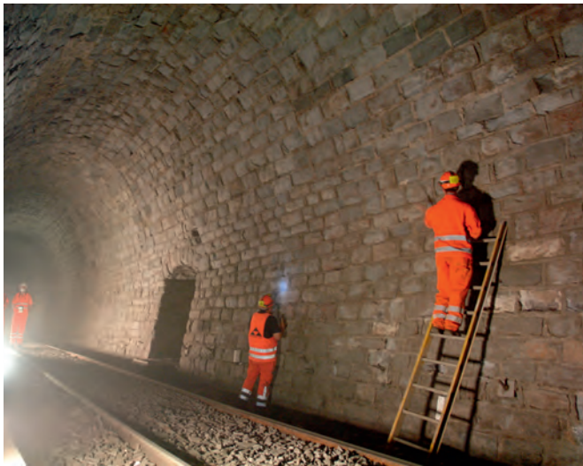
Tunneluntersuchung nach Bergung der ausgebrannten Güterwagen Investigating the tunnel following retrieval of the burnt out goods cars
