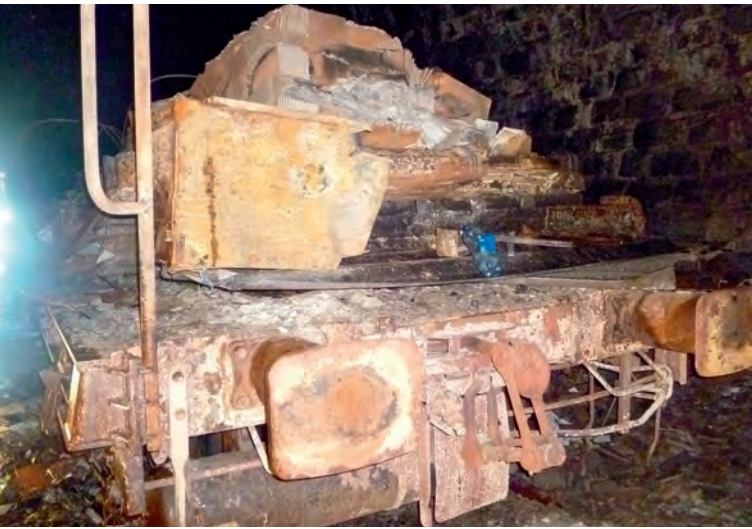
Güterwagen im Tunnel mit verbrannter Ladung Goods car in the tunnel with burnt out load
