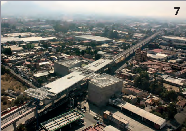
Luftaufnahme eines oberirdischen Metrobahnhofs Aerial photo of a surface Metro station
