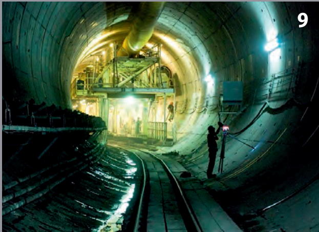
Ausbau der M-12-Röhren mit Stahlbetontübbing Lining the M-12 tubes with reinforced concrete segments
