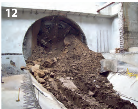
Durchbruch der TBM in die Station Parque de los Venados TBM breakthrough into Parque de los Venados station
