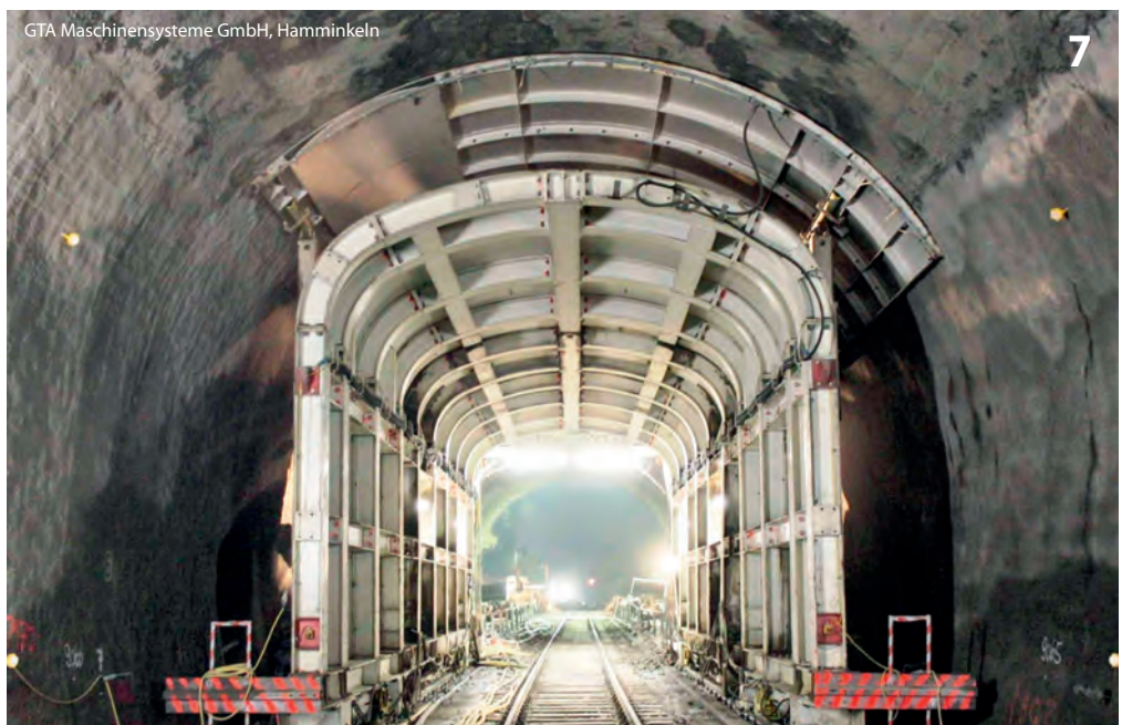
Tunnel-Aufweitung mit Tunnel-im-Tunnel-Methode – mit Stützplatten in der Firste zur Verbruchsicherung
