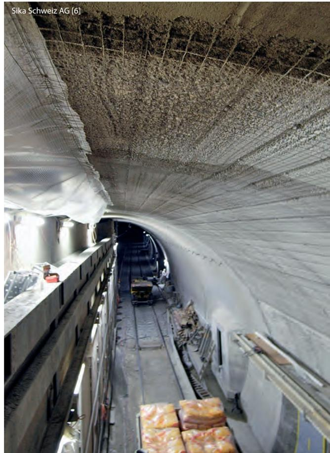
Schichtaufbau Brandschutzmörtel mit Stahlnetzbe wehrung
