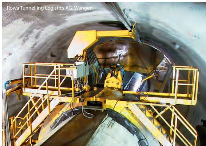
TVN-Nachläufer mit Spritzbetonroboter für maschinellen Tunnelvortrieb
