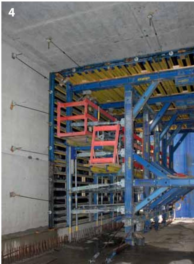
Für einfaches Ausschalen ist die Wandschalung rückspindelbar. Sie ist aus den besonders tragfähigen Verbundschalungsträgern I tec 20 aufgebaut.
