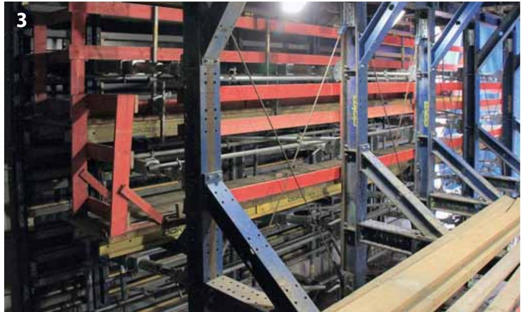
Der Tunnelschalwagen aus dem Traggerüstsystem SL-1 lässt sich statisch optimal auslasten. Die Ableitung der hohen Lasten aus Wand und Decke erfordert lediglich fünf Querscheiben je 10,50 m Schalwagenlänge.
