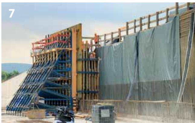
Wegen der ein-, zum Teil zweifachen Wanddickenversprünge von 15 bzw. 50 cm innerhalb eines Schalungselements entwickelten die Doka-Projektgenieure eine ausgeklügelte Lösung bei gleichzeitig minimaler Schalungsvorhaltung.
