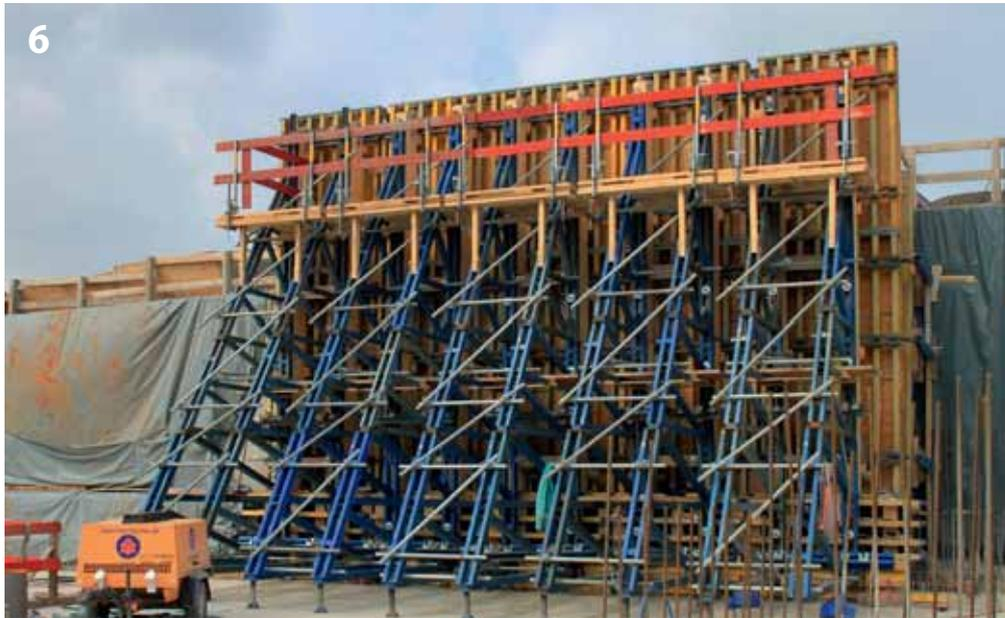
Die bis zu 9 m hohen einhäutigen Trogwände am Tunnel Hahnenkamp entstehen aus mietbaren Systemteilen der Trägerschalung FF20 und Doka-Abstützböcken.
