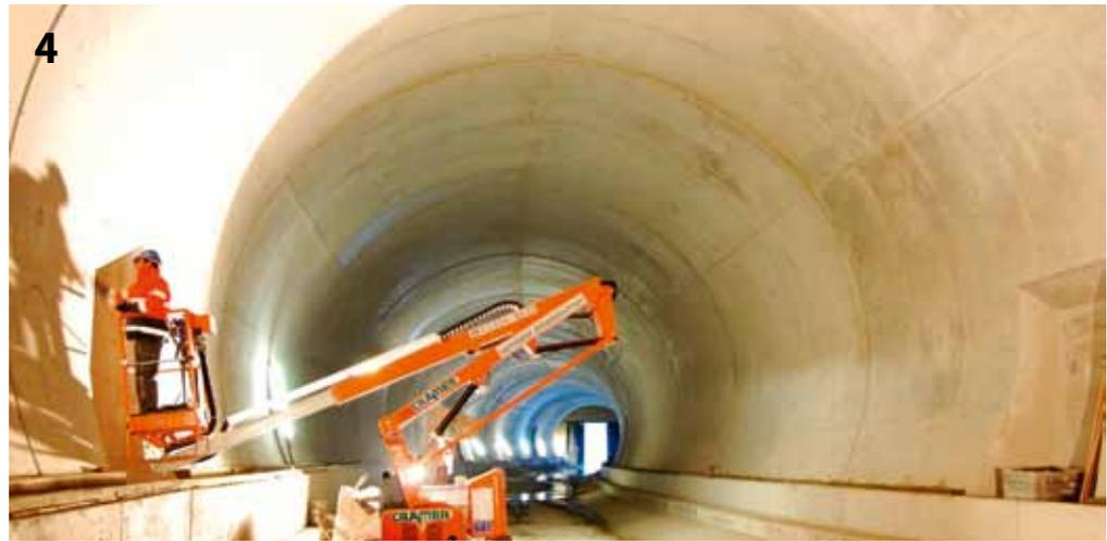
Innenschale aus PP-Faserbeton am Bühlentunnel
