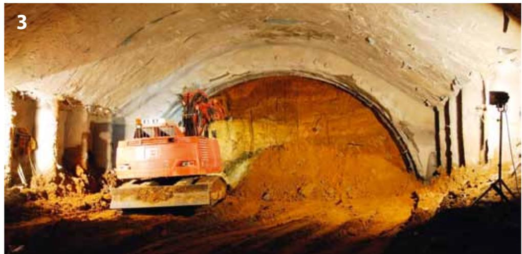
Vortrieb im Bereich der Deckelbauweise
