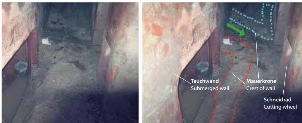
9 Abbaukammer bei Drucklufteinstieg mit Vollabsenkung der Suspension: Verklebungsmauer vor Tauchwandöffnung (Mauerkrone zwischen roten Linien) und dahinter angestautes Ausbruchsmaterial mit Restsuspension. Im Hintergrund ist undeutlich eine der beiden Verklebungsmauern an der Schildschneide erkennbar (Mauerkrone zwischen blauen Linien). Die Wirkrichtung einer Spüldüse ist als grüner Pfeil markiert
