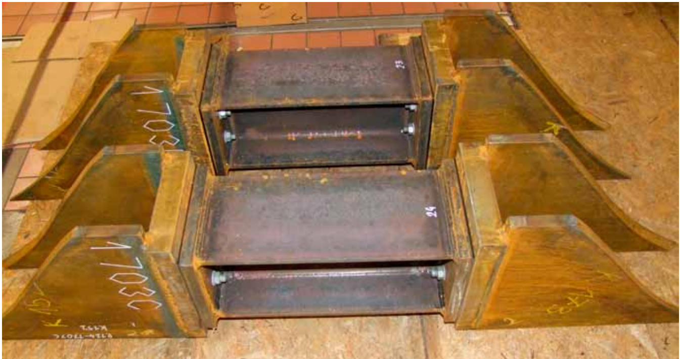
7 Vormontage der Aussteifungen auf dem Bahnsteig der Stadtbahnstation Pre-assembly of the reinforcements on the platform of the urban transit station
