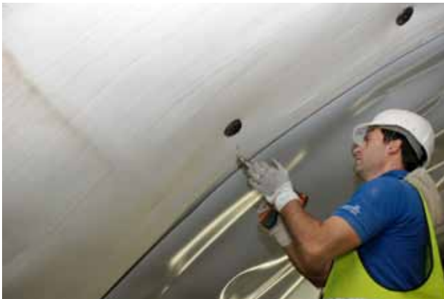
7 Installation der Rondellen Installing the rondelles
