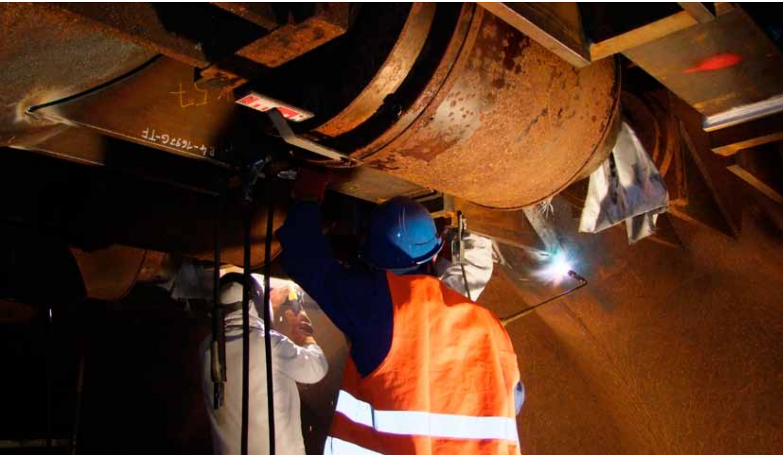
8 Vorwärmen und Schweißen der Stegbleche an die Tunnelschale Preheating and welding the web plates to the tunnel shell
