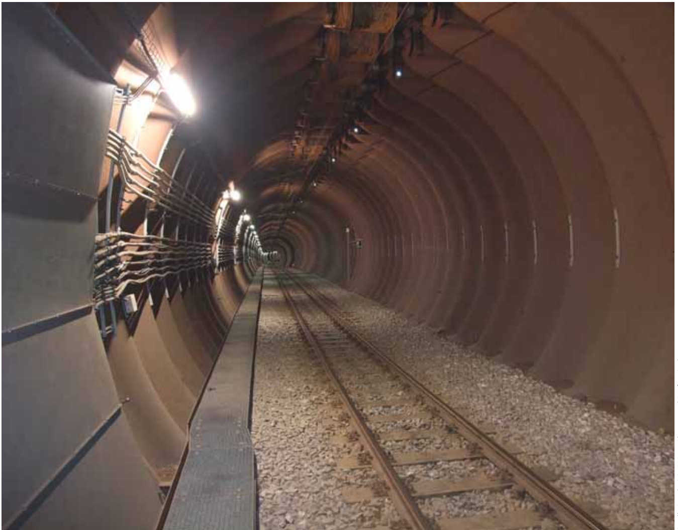
Quelle/Credit (2): ZERNA Planen und Prüfen GmbH
