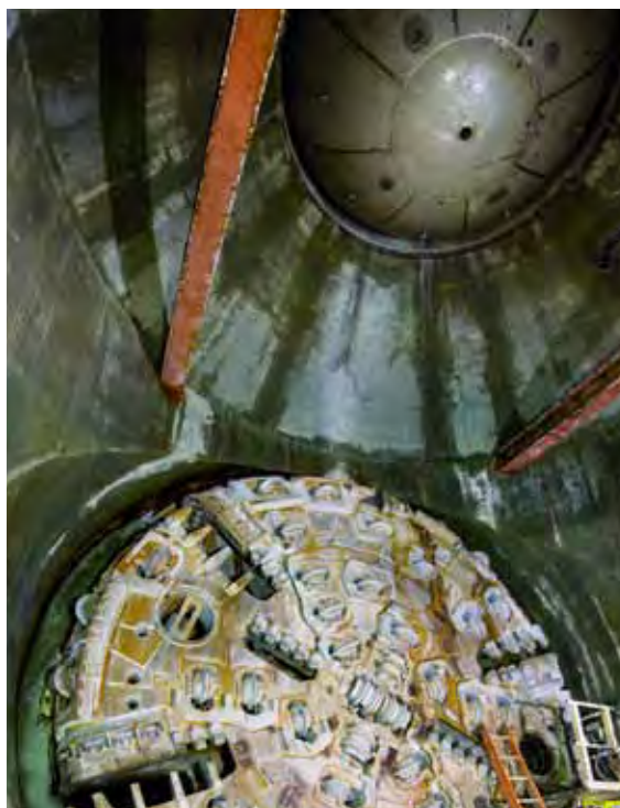
Herrenknecht Multi-Mode-TBM am Ziel unter dem Lake Mead
