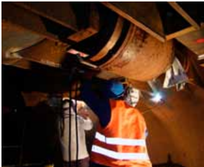
Tunnelertüchtigung gegen Einwirkungen aus Abgrabungen für den Abwasserkanal Emscher: Einbau zusätzlicher Aussteifungen im Stadtbahntunnel Gelsenkirchen
