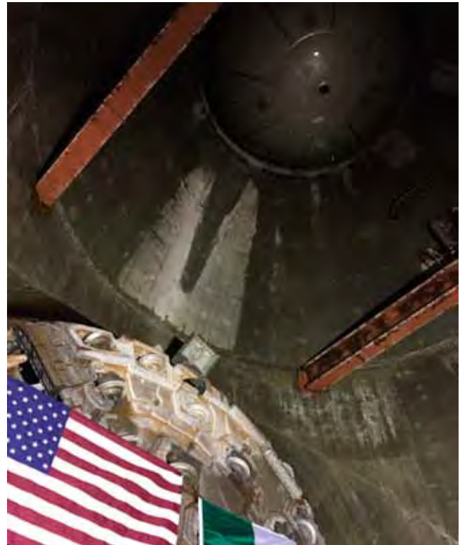
Die Herrenknecht TBM S-502 im Einlaufbauwerk. Die Druckwand trennt den See vom Tunnel
