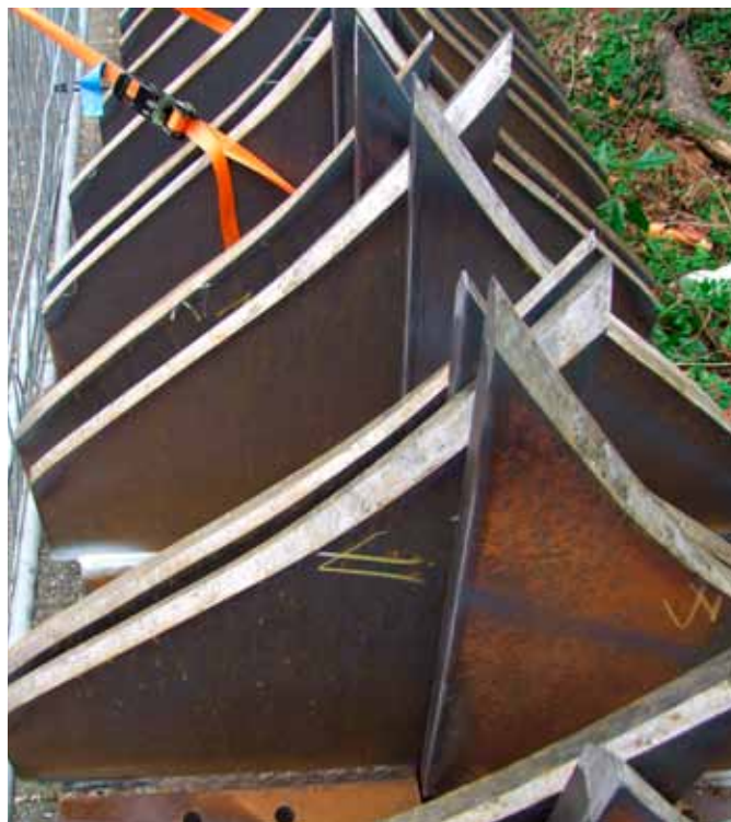
6 Konsolen der Aussteifungen mit passgenau gefertigter Kontur der Stegbleche
