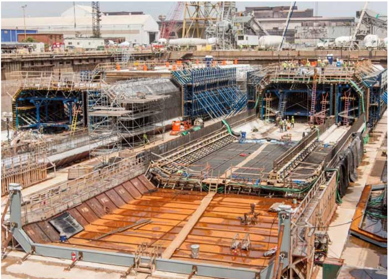
Insgesamt elf Tunnelsegmente mit je 106 m durchschnittlicher Länge wurden im Trockendock in Maryland mit Schalung betoniert
