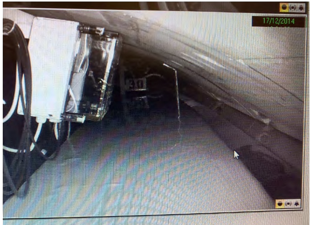
11 Tunnel zu 90 % verfüllt Tunnel 90 % backfilled
