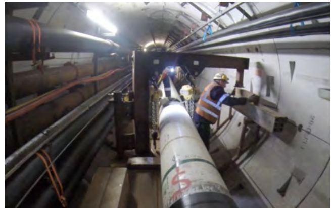
8 Einbau der Rohrschüsse im Tunnel Installing the pipe column in the tunnel
