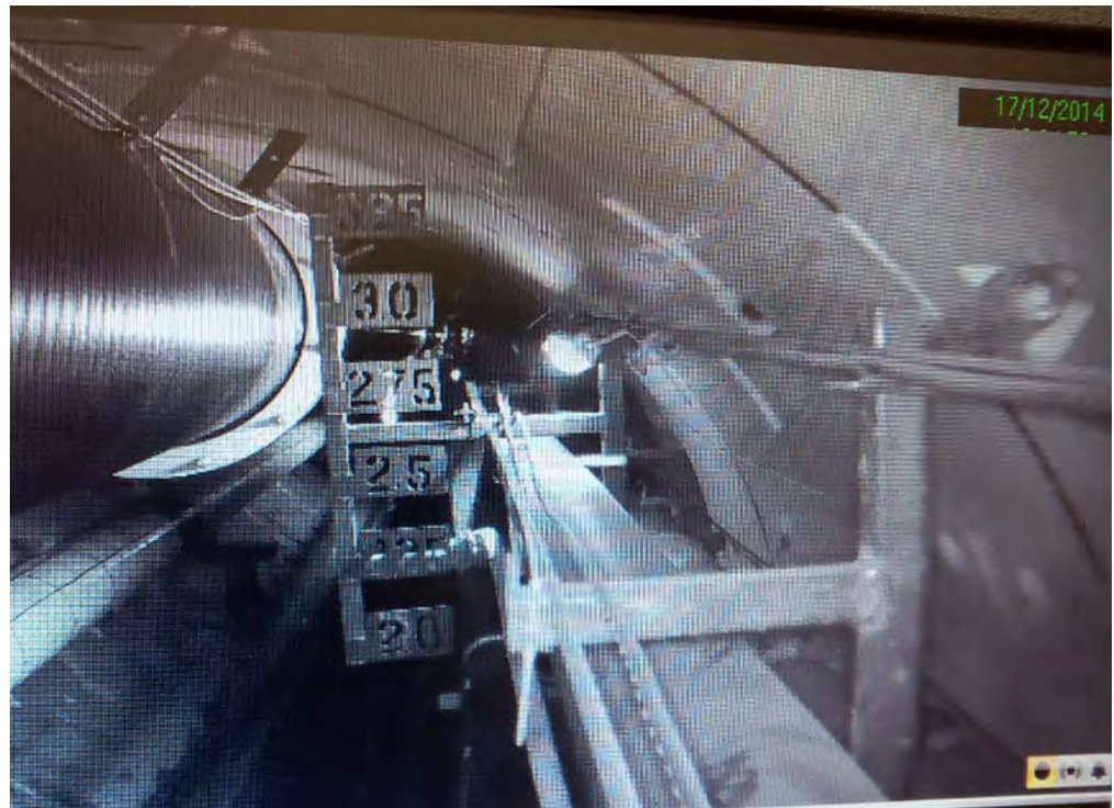
10 Tunnel vor der Verfüllung Tunnel prior to backfilling
