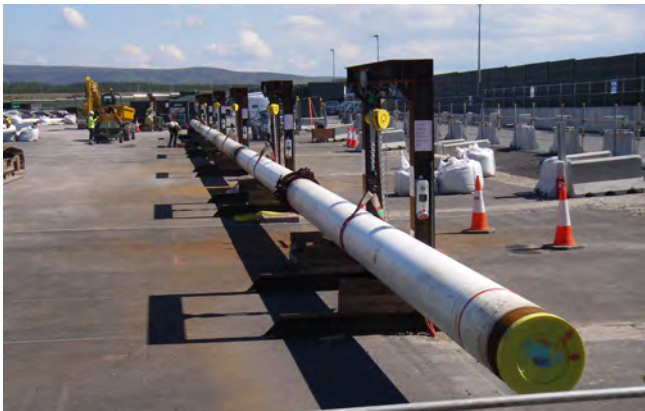
7 Zusammenstellung der Rohrschüsse Assembling the pipe column
