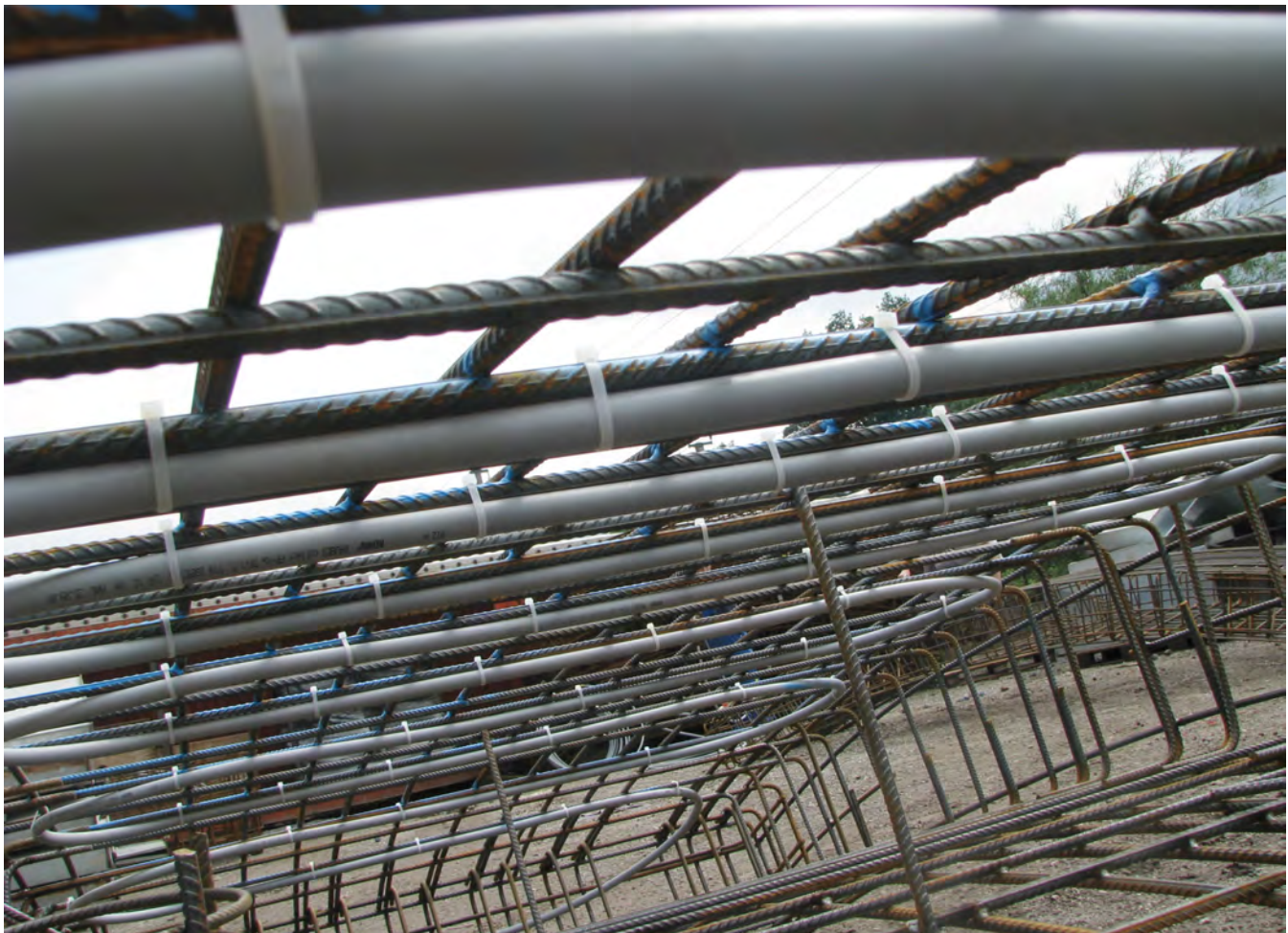
3 Herstellung des Energietübbings: Die Absorberleitungen (grau) werden an der Bewehrung befestigt Production of a geothermal segment: The absorber pipes (grey) are attached to the reinforcement
