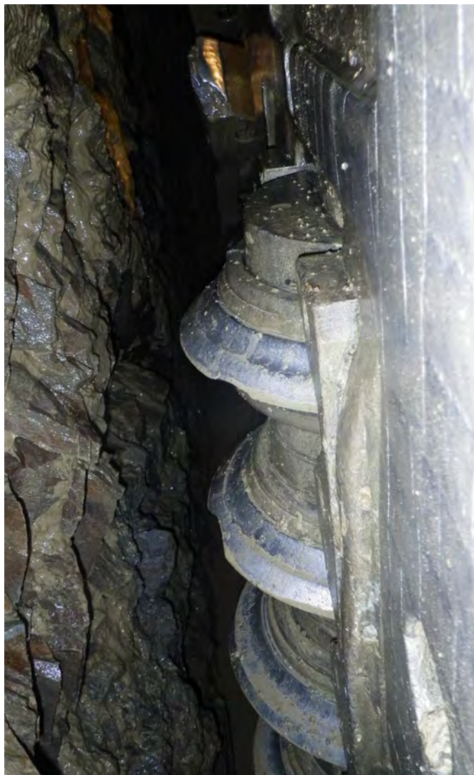
6 Ortsbrust und Schneirad mit Disken Face and cutting wheel with discs
