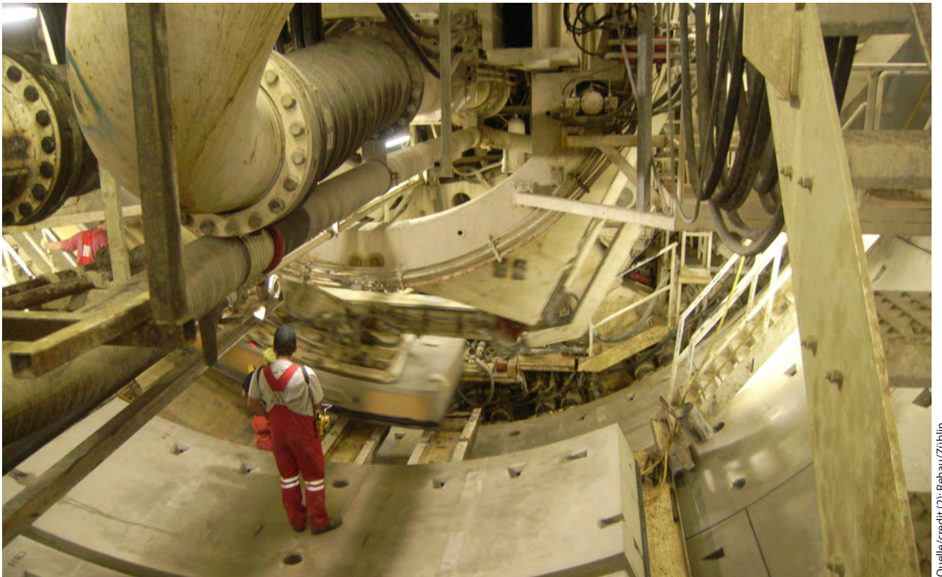
1 Einbau der Energietübbings im Tunnellos H8 Jenbach
