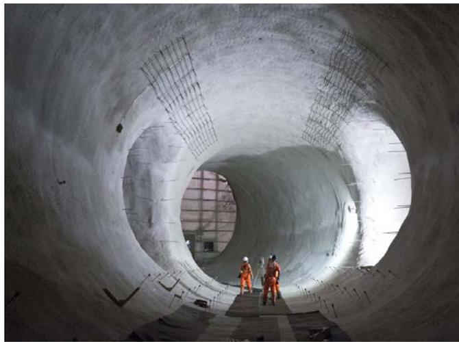
7 „Wrap Around“ mit bereits entferntem Porenbeton und Tübbingausbau vor Beginn der Plattfortarbeiten in Spritzbetonbauweise
