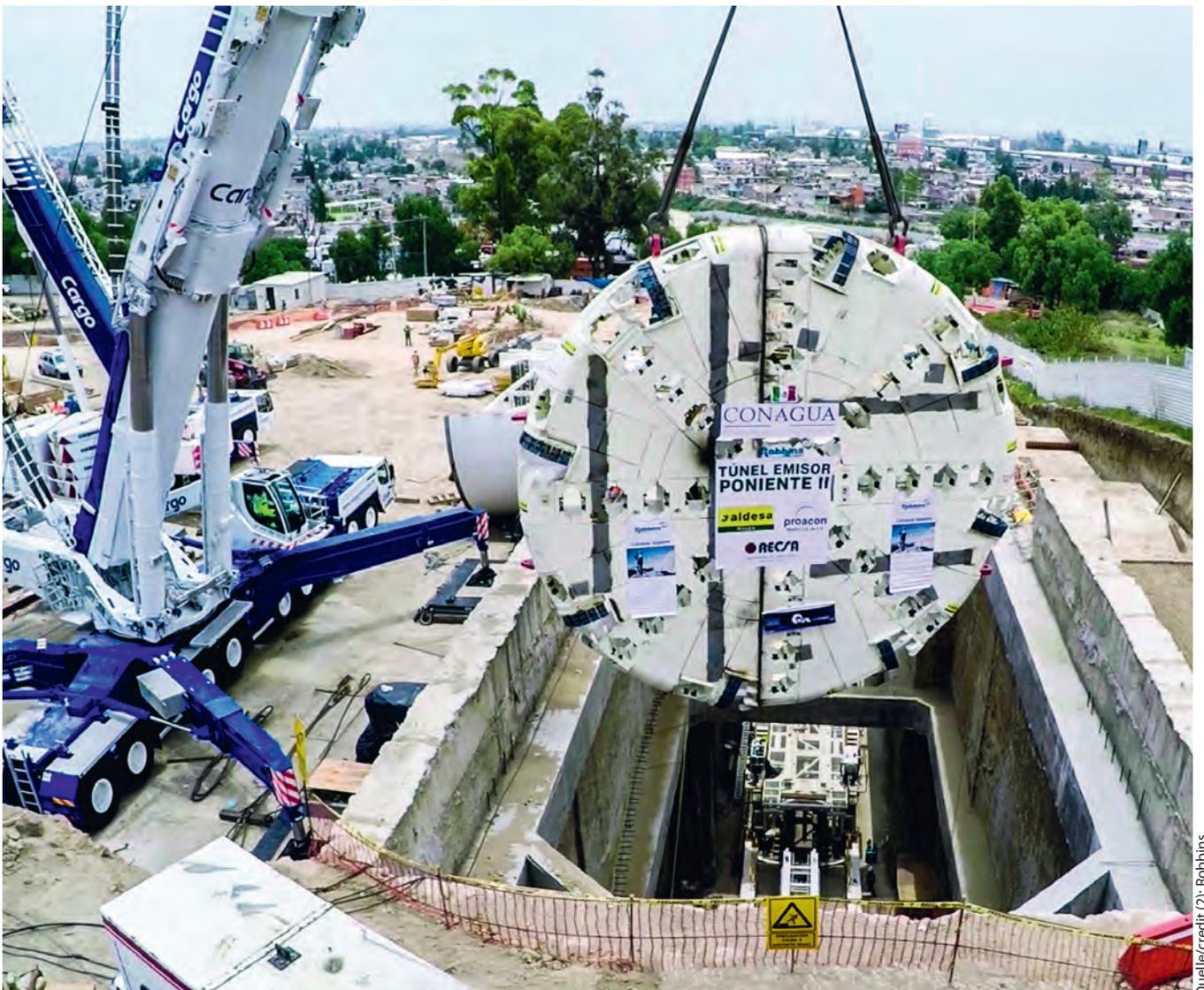
Die Bauteile der Crossover-XRE-Maschine mit einem Schilddurchmesser von 8,7 m mussten in einen nur 11 m breiten Startschacht hinabgelassen werden
