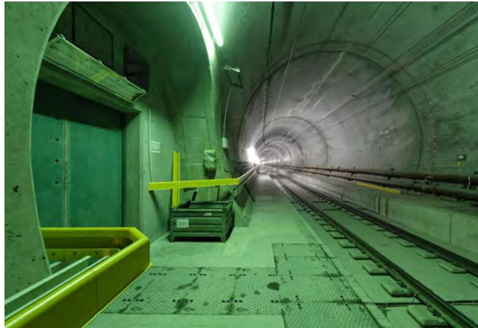
Alle 300 Meter verbindet ein Querschlag die beiden Tunnelröhren. Eine massive Brandschutztür sichert die Querschläge. Im Brandfall können die Zugpassagiere durch die Querschläge in die andere Röhre flüchten. Das Leitsystem aktiviert die Fluchtsignale und nutzt die Türen, um Rauch gezielt abzusaugen
