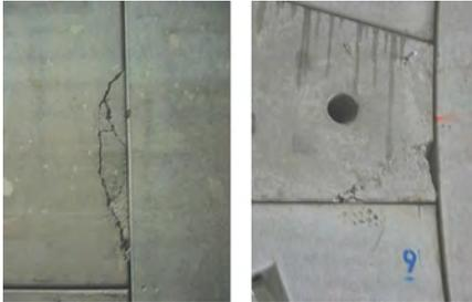
Die Qualität der Ringspaltverfüllung unterliegt in der Praxis großen Schwankungsbreiten. Bei einer ungenügend auf den Baugrund abgestimmten Mörtelrezeptur können in den Bau- und Montagezuständen der Tübbingringe Beschädigungen in Form von Abplatzungen, Rissbildungen und Versätzen sowie Undichtigkeiten entstehen
