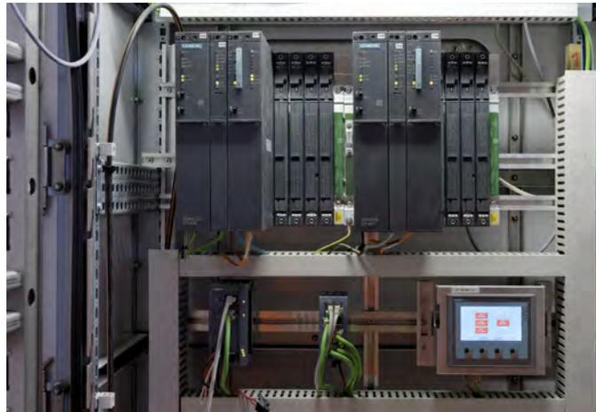
Redundante, hochverfügbare Simatic S7-400H steuern die kombinierten hydraulischen und elektrischen Antriebe der Spurwechsellöre. Sämtliche Komponenten sind durchgängig über Ethernet vernetzt
