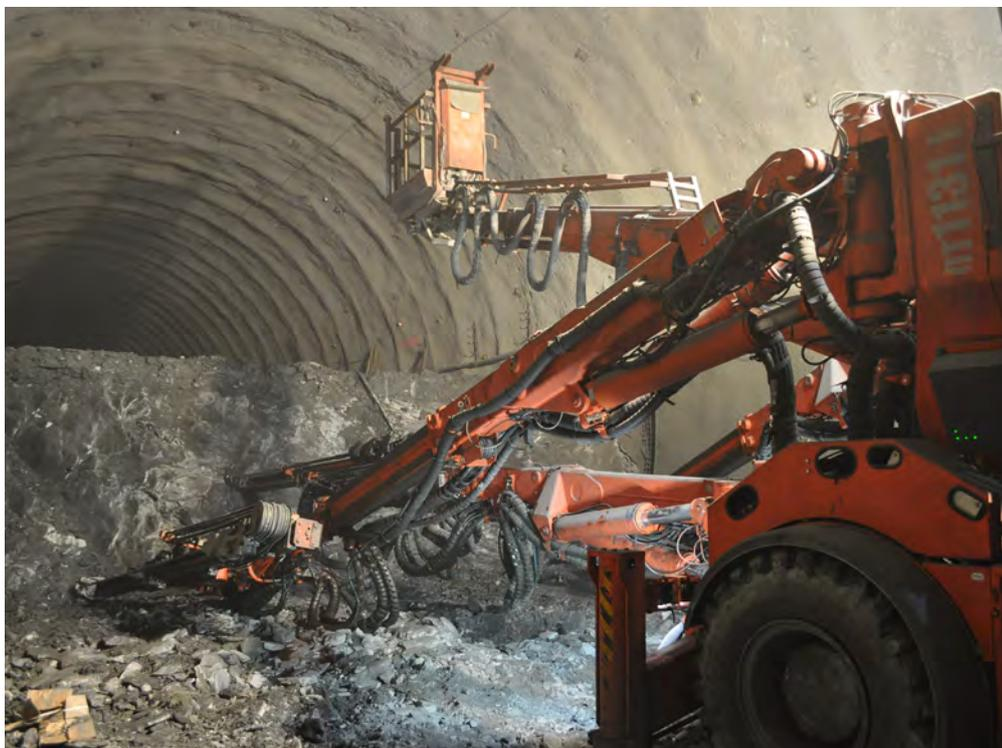
**Technische Daten****Sandvik Bohrgerät DT1131-SC**
