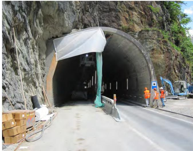
Bei der Sanierung des Tunnels Zuben wurde die die chloridbelastete Betonschale teilweise abgebrochen, die Bewehrung gereinigt und wo nötig ersetzt und eine neue Innenschale aus Spritzbeton mit synthetischen Fasern erstellt
