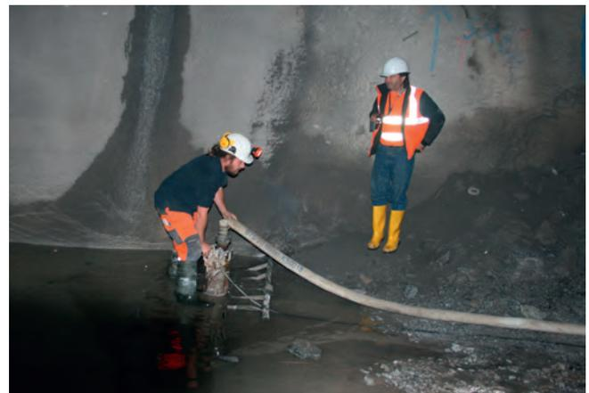
Eine SPT Tauchwasserpumpe wird positioniert
