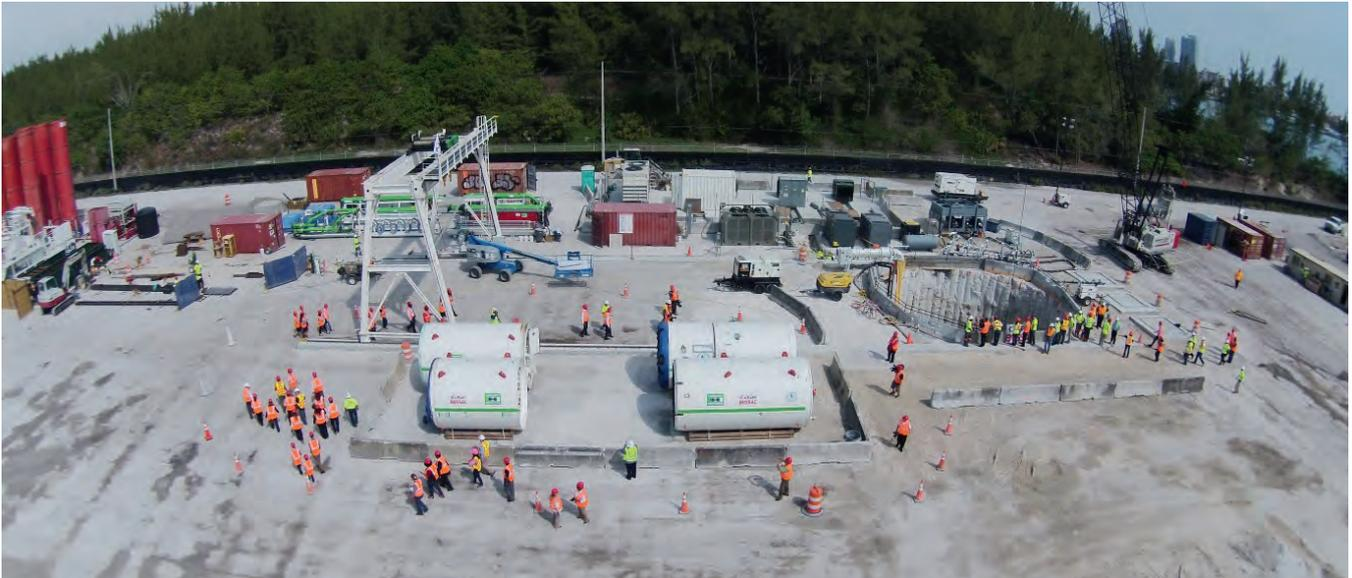
Der im Durchmesser nur 12 m große Startschacht auf Virginia Key sparte Platz. Die HCS-Maschine musste den Vortrieb aufgrund dessen jedoch im Rohrvortrieb mit Hilfe eines Presserahmen-Adapters beginnen
