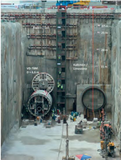
Für die Variable-Density-TBM (VD-TBM) von Herrenknecht wurde ein Stützmedium mit erhöhter Dichte entwickelt, welches den Übergang von flüssig zu pastös zuverlässig abdeckt – das High Density Support Medium (HDSM). Foto: Montage der ersten VD-TBM S-774 im Startschacht Cochcrane in Kuala Lumpur, Malaysia, im März 2013
