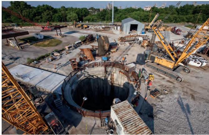
Die TBM wurde vom 67 m tiefen White-River-Schacht aus gestartet um sowohl den Lower-Pogues-Run- als auch den White-River-Tunnel zu bohren
