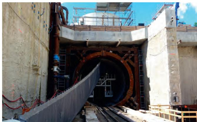
2 Bei der fliegenden Schildanfahrt kann auf aufwendige Rücksteifkonstruktionen sowie den Bau einer Blindröhre in der Startbaugrube verzichtet werden
