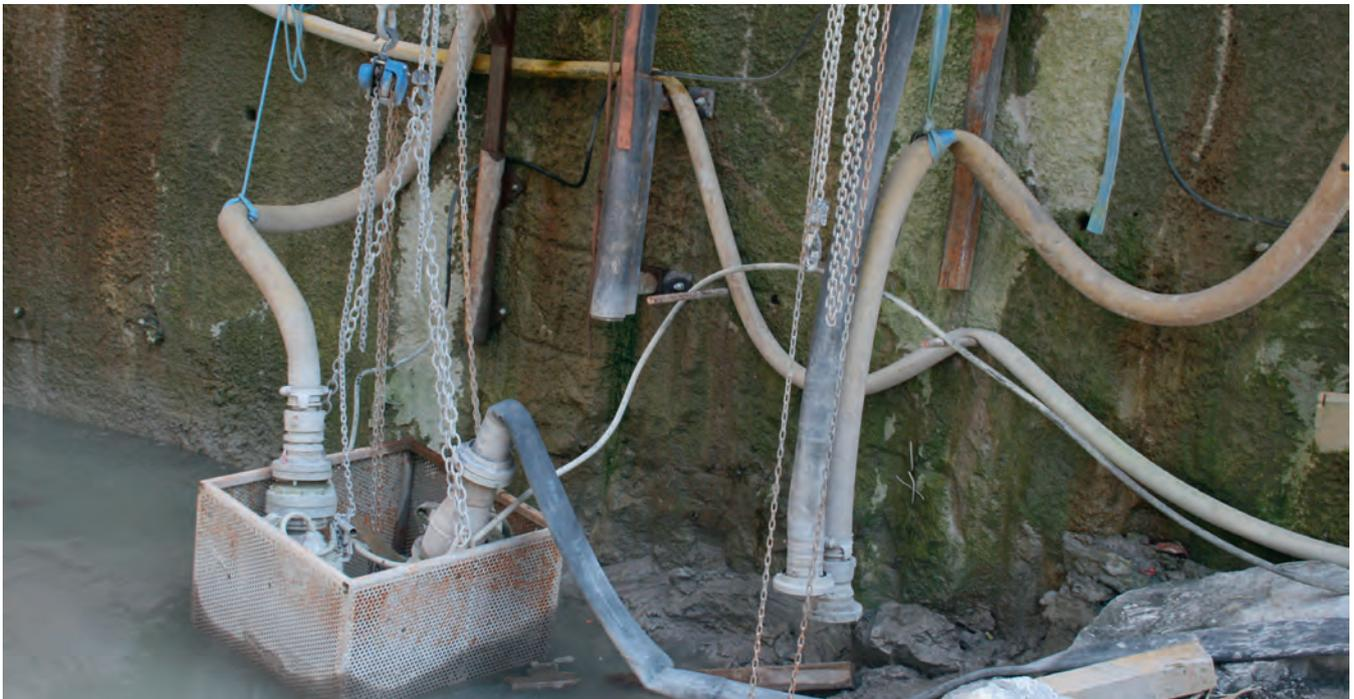
SPT-R Schmutzwassertauchpumpen verfügen über ein Rührwerk für die Förderung problematischer Sand-Wasser-Gemische
