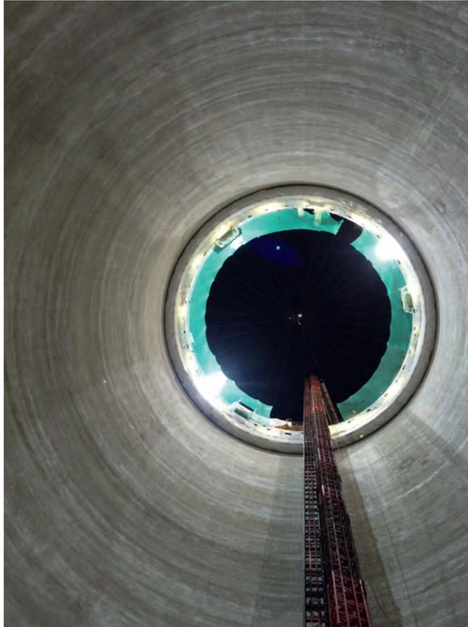
Stahlfaserverstärkte Innenschale des Hauptzugangs- und Pumpenschachts im Lee-Tunnel
