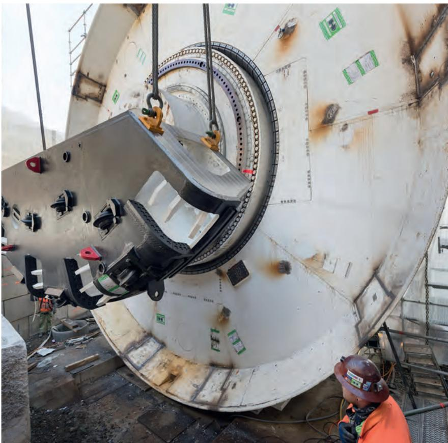
Montage des TBM-Schneidrads
