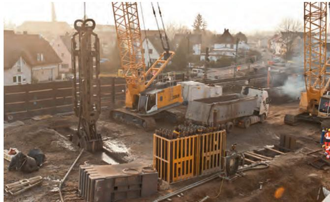
Aushub einer zirka 40 m tiefen Schlitzwandlamelle, in die im Anschluss Bewehrungskörbe eingelassen werden
