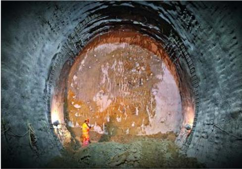
Beim Neubau des Albulatunnels II in der Raibler Rauwacke wurde für den Vortrieb in der geologisch schwierigen Zone aus siltigem Feinsand unter hohem Wasserdruck ein Gefrierkörper erstellt. Foto: Vortrieb im Gefrierkörper
