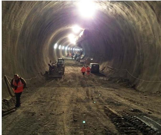
Der neue Pforzheimer Tunnel wurde in Spritzbetonbauweise gebaut. Dabei mussten etwa 600 m im Fels und etwa 300 m im Lockergestein durchörtert werden
