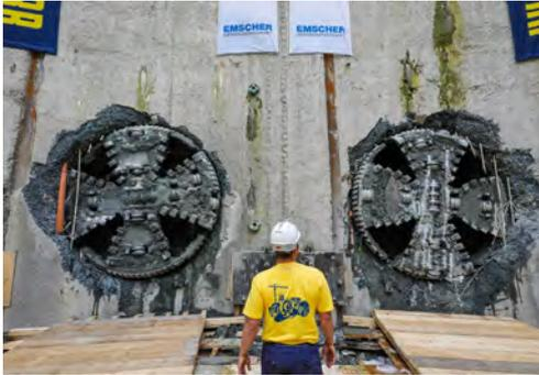
Mit dem Durchbruch der beiden letzten Tunnelbohrmaschinen in die Zielgrube des Bauabschnitts 40 in Oberhausen, Deutschland, sind seit dem 12. Juni 2017 die Tunnel- und Rohrvortriebsarbeiten für den Abwasserkanal Emscher (AKE) abgeschlossen
