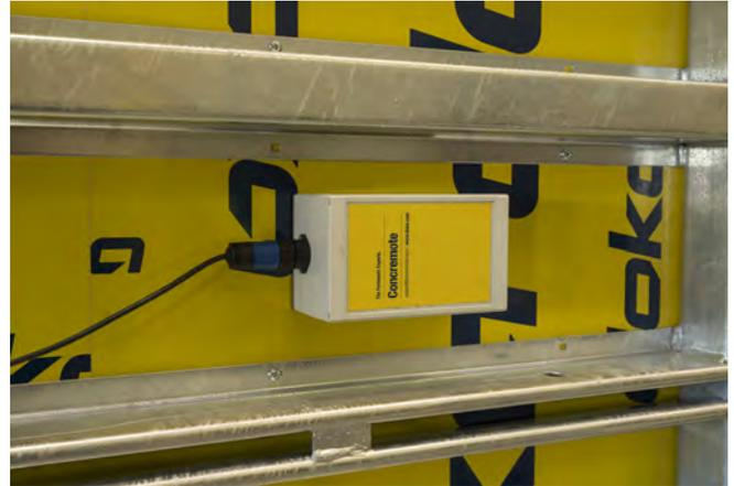
Einsatz eines Concremote Kabelsensors bei der Sanierung der Galerie Senftenberg an der A12 in Österreich
