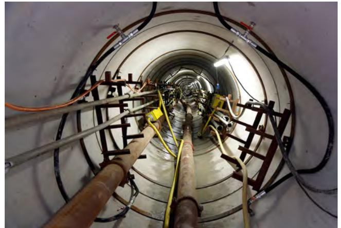
Mit einem Innendurchmesser von 2,6 m zählen die Doppelröhren im Bauabschnitt 40 zu den kleinsten Tübbingtunneln der Welt
