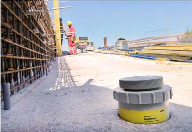
Concremote Deckensensor im Einsatz auf der Tunnelbaustelle des Südgürtels Graz, der im Mai 2017 für den Verkehr freigegeben wurde
