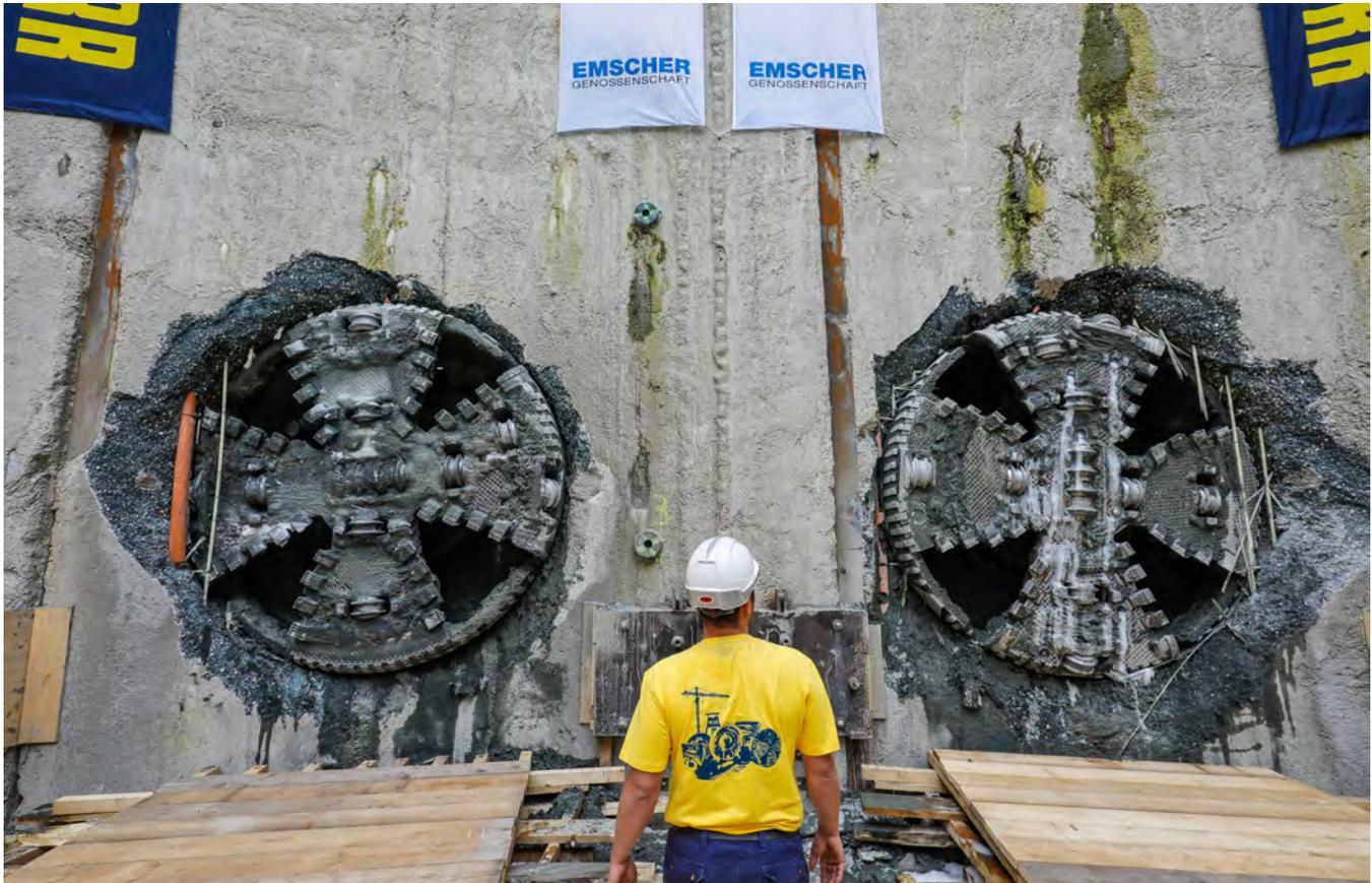
Am 12. Juni 2017 durchstießen die beiden EPB-Schilde im Bauabschnitt 40 des Abwasserkanals Emscher präzise die Zielwand beim Pumpwerk Oberhausen. Damit sind die Tunnel- und Rohrvortriebsarbeiten für die Renaturierung der Emscher planmäßig abgeschlossen worden
