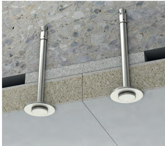
Die Befestigung der Aestuver Tx Brandschutzplatte erfolgt mit Schrauben bzw. Nagelankern auf systemkompatiblen Hinterlegstreifen
