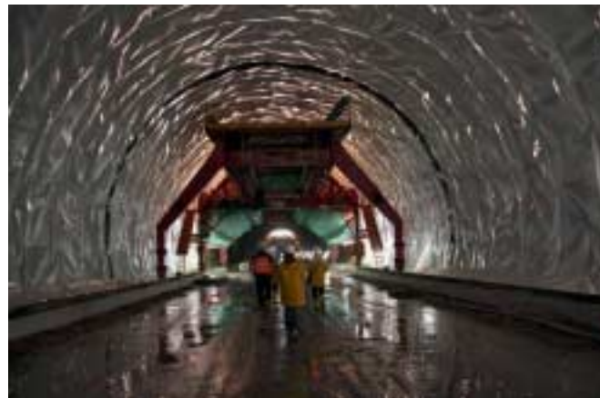
Foto 1 Ausbaurbeiten im Bleißberg-Tunnel, NBS Erfurt–Leipzig/Halle
