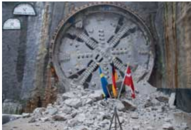
1 Durchstich Vortriebsanlage Citytunnel Malmö, EPB-Schild mit 8,89 m Durchmesser
