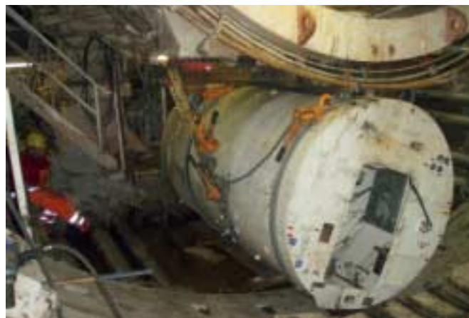
4 Transport der Schleusen während der Umbauphase
