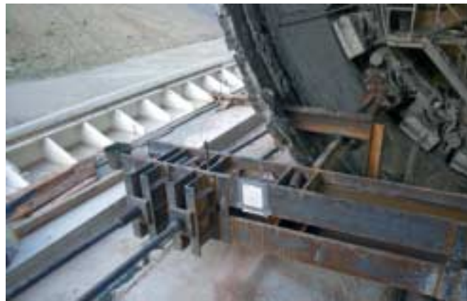
7 Querjoch im hinteren Teil der Verschubkonstruktion
