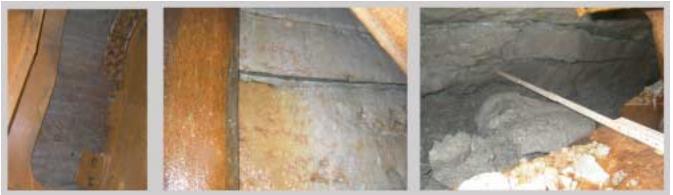
2 Geotechnische Verhältnisse an der Ortsbrust
