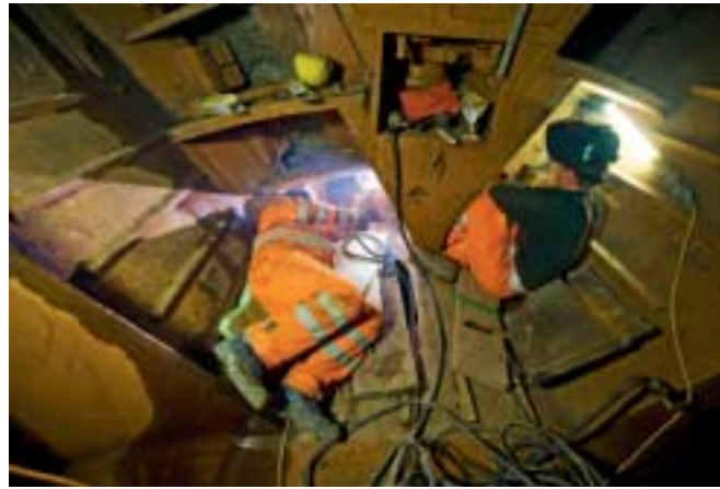
3 Erschwerte Bedingungen für die Schweißarbeiten am Schneidrad von hinten
