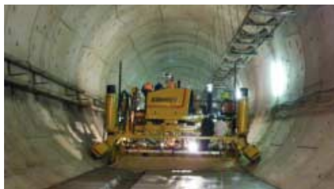
8 Betonsohlerstellung mit Fertiger im Pilgerschrittverfahren
