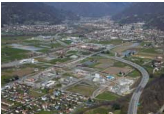
2 Luftaufnahme der Baustelle Nodo di Camorino
