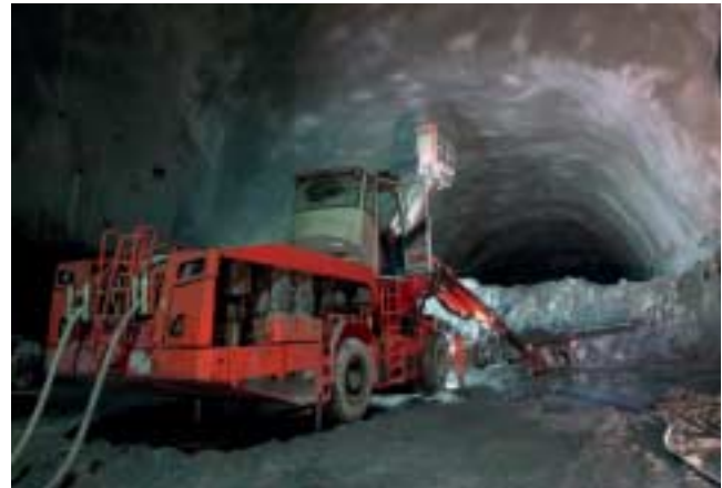
5 Ausbruch der Caverna Operativa West: Anker im Profilwechsel der Einspurröhre
