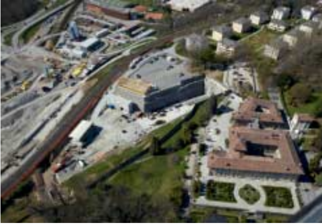
6 Voreinschnitt Vezia, im Vordergrund Villa Negroni 6 Vezia pre-cut, the Villa Negroni in the foreground
