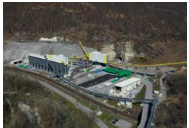
3 Übersicht Baustelle Sigirino, im Zentrum der Fensterstollen FIS
