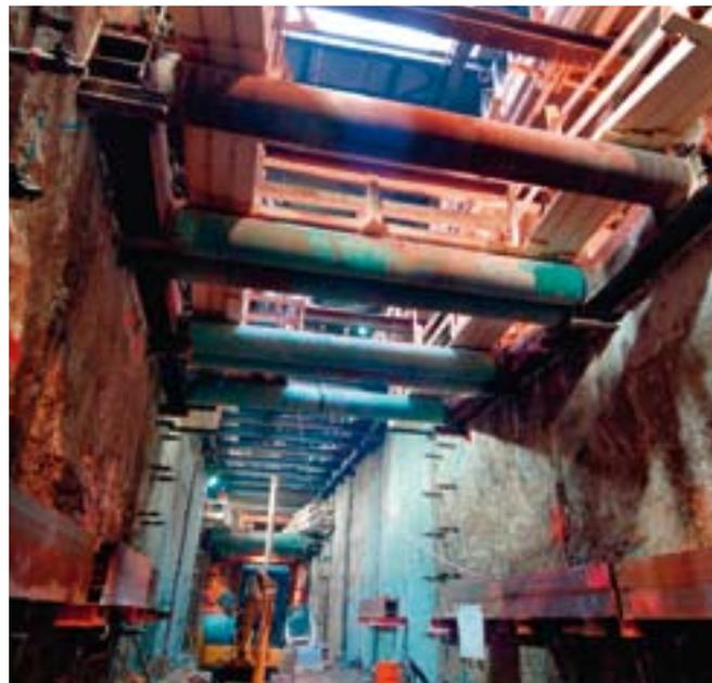
2 Aushub- und Betonierarbeiten für die Nord-Süd Stadtbahn Köln
