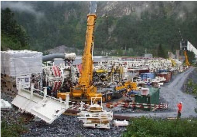
5 Tunnelvortriebsanlage bei der Montage
