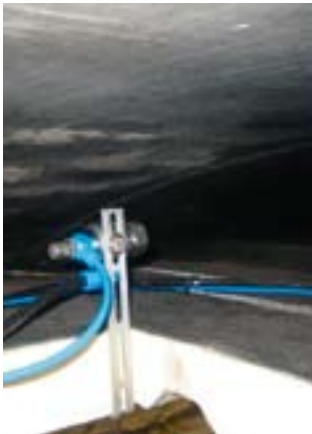
3 Düsen vernebeln 1 bis 2 l Wasser pro Stunde
