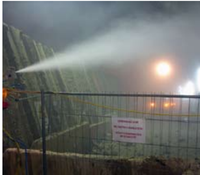
7 Wassernebel zur Staubreduktion in Schutterbereichen
