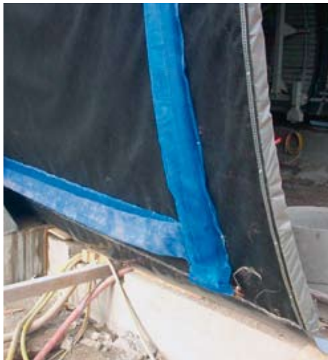
2 Luftpolster schaffen Abgrenzung zwischen Frischbeton und Nachbehandlungswagen
