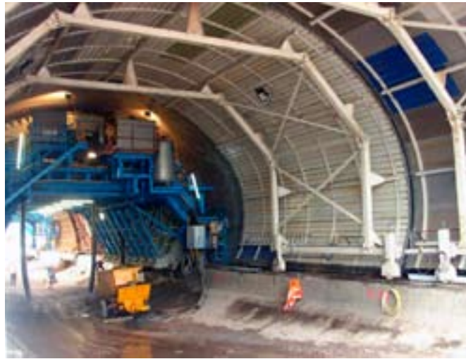
1 Betonierwagen mit angekoppeltem Nachbehandlungswagen
