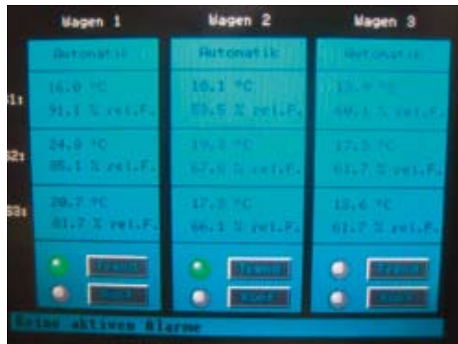
6 Anzeige der Temperatur- und Feuchtwerte im Display des Datenloggers
