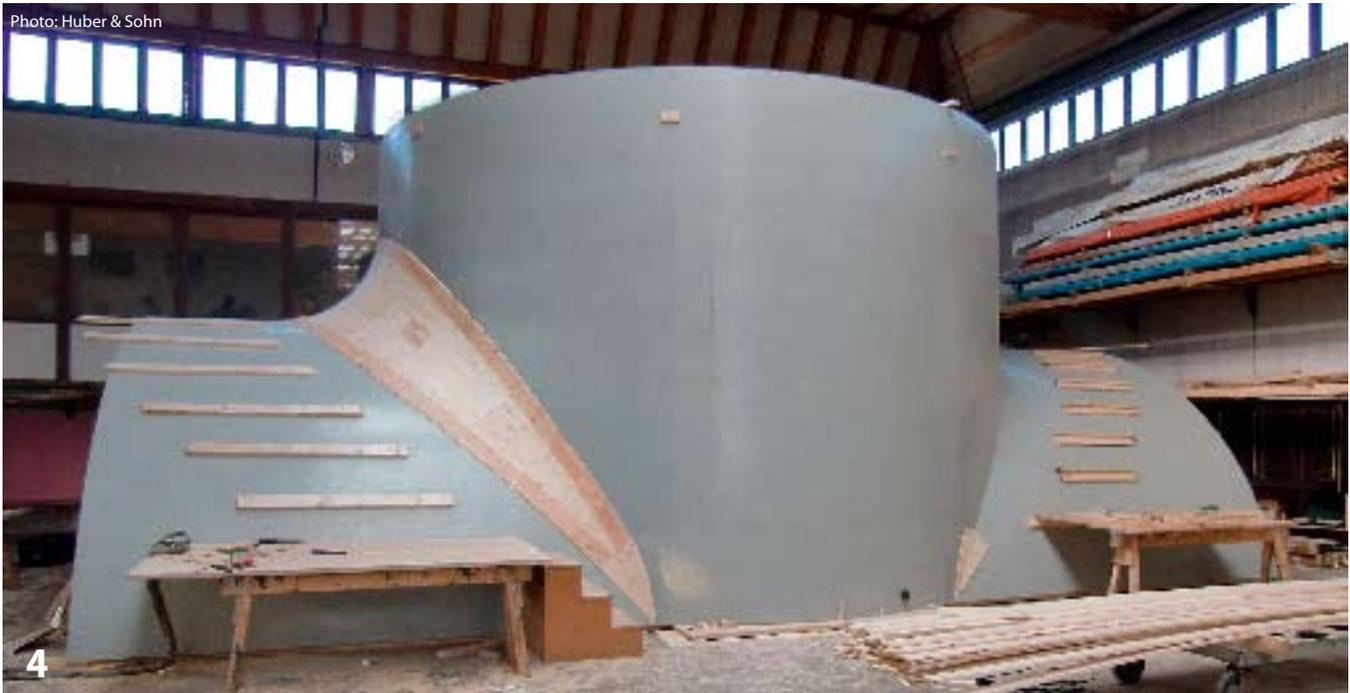
4 Kappenschalung des Entrauchungsquerschlages. Direkt auf der Kappenschalung sitzt der Schachtring mit 6,70 m Durchmesser. Gut zu sehen ist der abgerundete Übergang von Gewölbe zum Schachtring. Gebaut wurde zuerst die Tragkonstruktion mit Spanten. Anschließend wurde sie mit Brettschalung belegt, geschliffen und lackiert.
