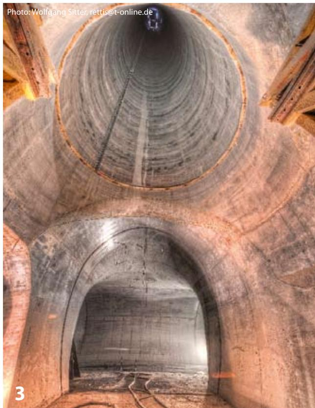
Blick aus dem Entrauchungsquerschlag in Richtung Haupttunnel und gleichzeitig in den 130 m hohen Entrauchungsschacht
