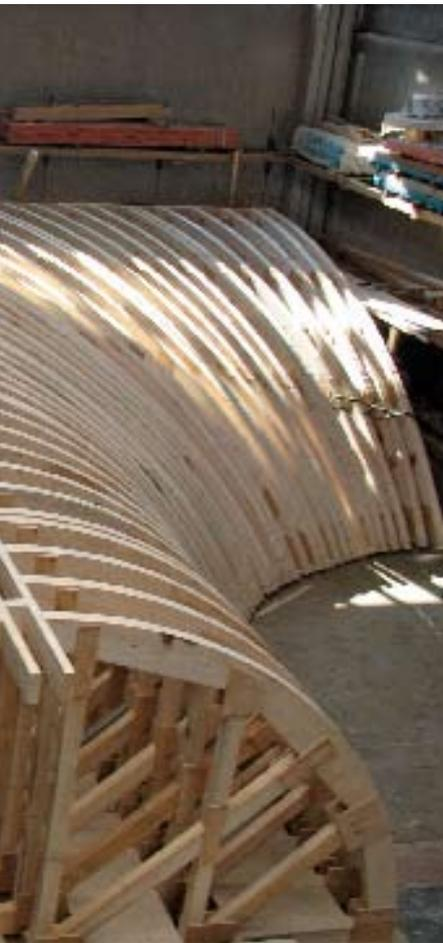
– dieser Übergang erfolgt auch noch in einem Radius. Etwa in Höhe der Kämpferlinie beträgt dieser planerisch 4,50 m; darüber und darunter musste der Radius ermittelt werden.
