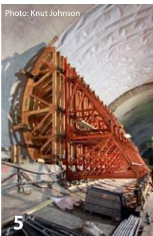
5 Gerade Ulmenseite des Haupttunnels mit Abstützböcken versehen beim Betonieren der Ulme
