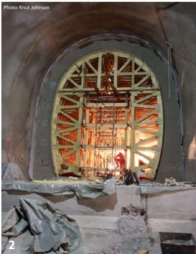
Gewölbeschalung, Ulme und Kappe, bereits betoniert, mit ausgeschalteter Stirnabstimmung
