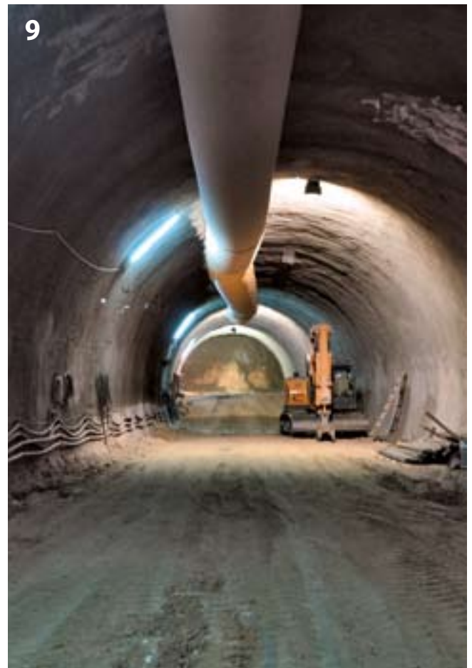
Der in NÖT ausgeführte Tunnel Tsarigradsko Chaussee The Tsarigradsko Chaussee Tunnel produced by the NATM
