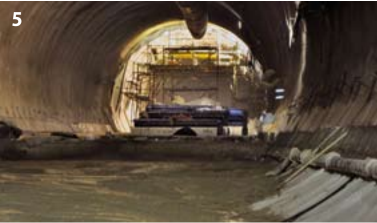
Verbindungstunnel Hemus, wo derzeit die Sohle betoniert wird Hemus connecting tunnel, where currently the floor is being concreted
