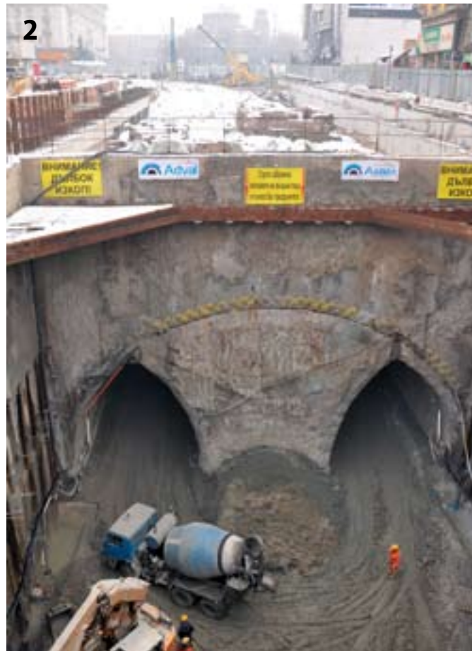
Baugrube Nord der U-Bahnstation 8-II: Im unteren Bereich sieht man die UImenstollen, im oberen Bereich die Ruinen, die unterquert werden mussten
