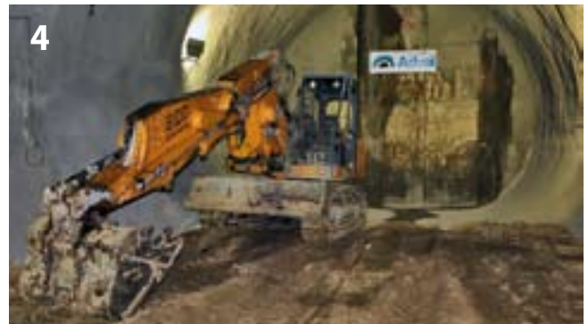
4 Verbindungstunnel Hemus zwischen U-Bahnstation 10 und 11 Hemus connecting tunnel between Metro stations 10 and 11
