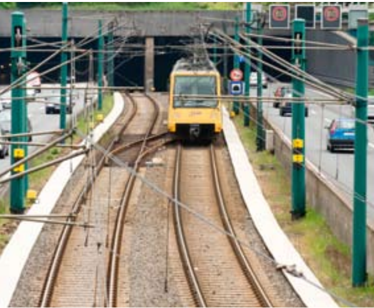
Die Trogabdeckungen im frei bewitterten Bereich wurden mit einer zusätzlichen Beschichtung aus Quarzsand in der Rutschhemmungsklasse R 13 ausgeführt
