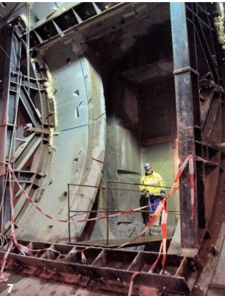
Rettungsschacht 5 im Tunnel Süd nach Öffnung Tunnel south at evacuation shaft 5 after opening
