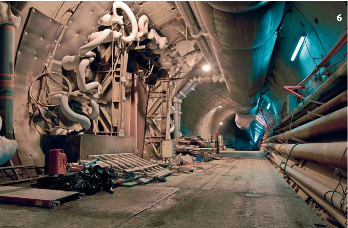
Tunnel Nord im Bereich des Querschlags 2, in dem Aushubarbeiten stattfinden Tunnel north at cross passage 2 under construction
