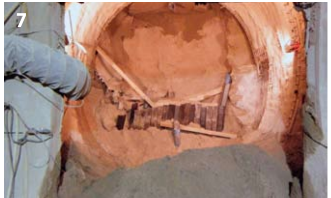
7 Vortriebshandwerk Grasbrookpark Driving operations Grasbrook Park
