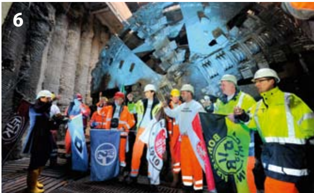
6 Zweiter Durchschlag im November 2010 Second breakthrough in November 2010
