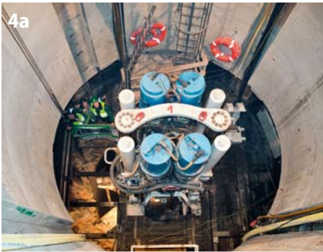
Durchbruch des RBR 550 VF am 18. Januar 2011 Breakthrough of the RBR 550 VF on January 18, 2011
