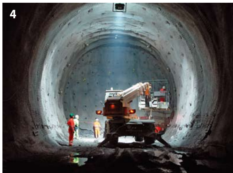
Ausbrucharbeiten Sigirino Excavation work at Sigirino
