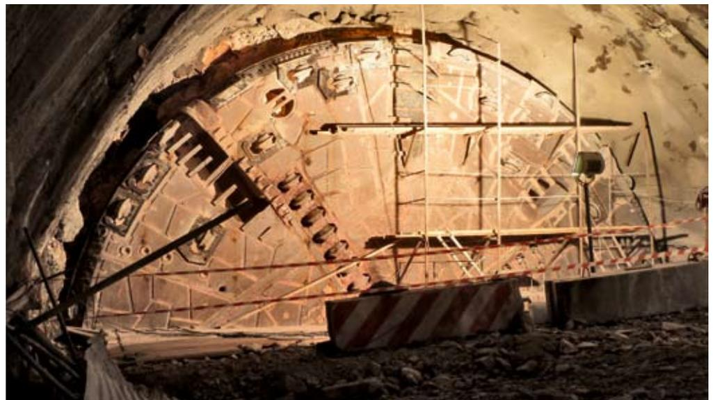
Verbruchmaterial in den Diskenkästen (links) und der freigelegte Bohrkopf (rechts)
