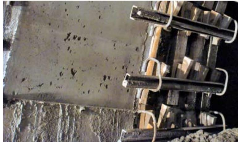
Ausbruchsicherung nach Russischer Methode und Detail mit Ortbeton und ausgesteifter Schalung (rechts)
