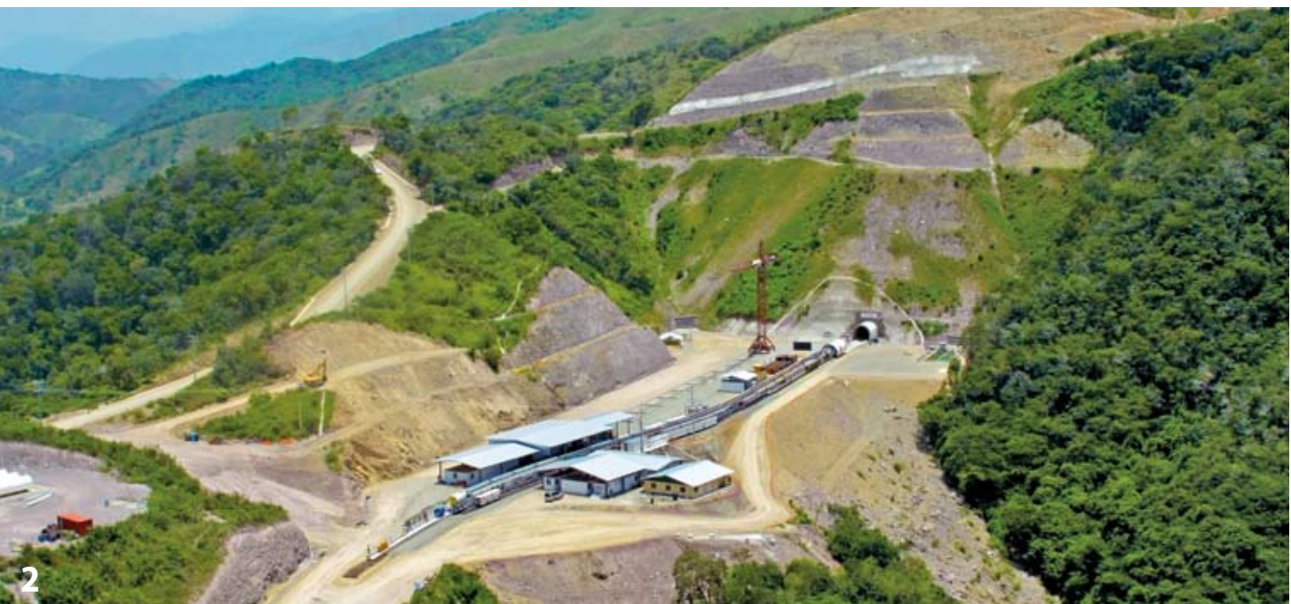
Hinter den Kulissen: Die Anfahrtsituation der TBM auf der Baustelle Palomino vor der Cordillera Central im Südwesten der Insel Behind the scenes: The TBM's launch site at the Palomino jobsite in front of the Cordillera Central in the island's south west
