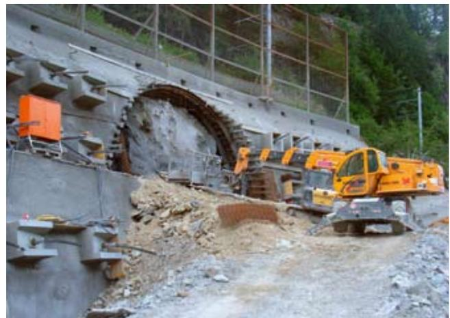
Der gesicherte Portalbereich unmittelbar unter einer Schmalspurbahnlinie für den 5,6 km langen Hauptzugangstunnel, der mit einer TBM von 9,45 m Durchmesser aufgeföhren wird
