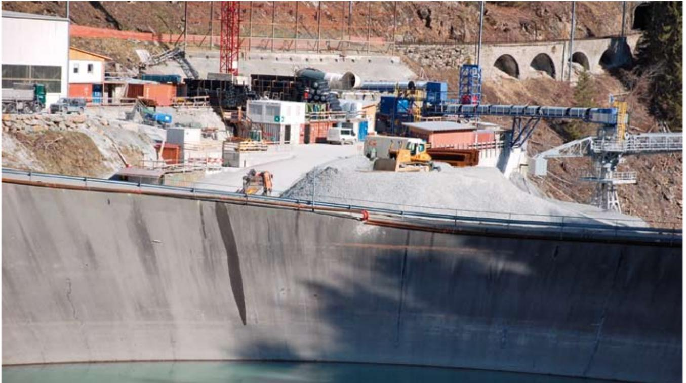
Übersicht über den Installationsplatz für das neue Wasserkraftwerk Nant de Drance im Wallis/CH zwischen Martigny und Chamonix/F. Mit einem 5,6 km langen, im Vortrieb befindlichen Tunnel wird der Zugang zu den Maschinenkavernen erfolgen
