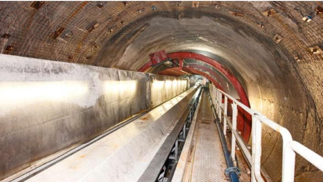
Für den Vortrieb des 5,6 km langen Hauptzugangstunnels im um gut 11 % steigenden Vortrieb wird eine modifizierte TBM von Herrenknecht eingesetzt, welche sich bereits in einem Los des Lötschberg-Basistunnels bewährt hatte
