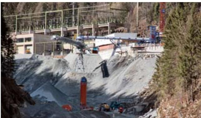
Für die Endablagerung von 1,2 Mio. m<sup>3</sup> Ausbruchmaterial steht eine Geländevertiefung zur Verfügung. Der Transport erfolgt über eine Bandanlage mit einer um 580 m fallenden Förderung und direkt vom Stollenportal aus mit einer schwenkbaren Schüttnanlage von Marti Technik
