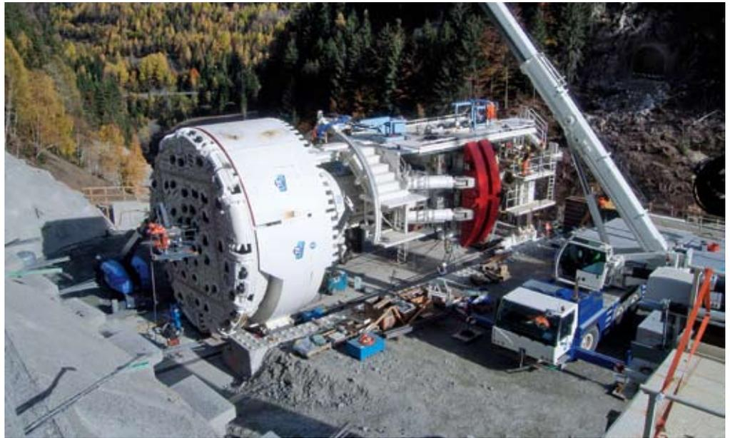
Mit der TBM mit einem Bohrkopfdurchmesser von 9,45 m konnten mit einer Drehzahl von 6 U/min gearbeitet und ein Vortriebsfortschritt von 12 bis 15 m erzielt werden
