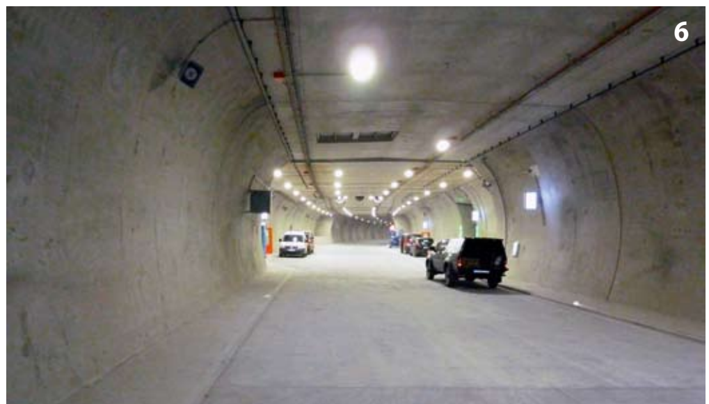
Im Dezember 2010 wurde der Pörzbergtunnel eingeweiht
