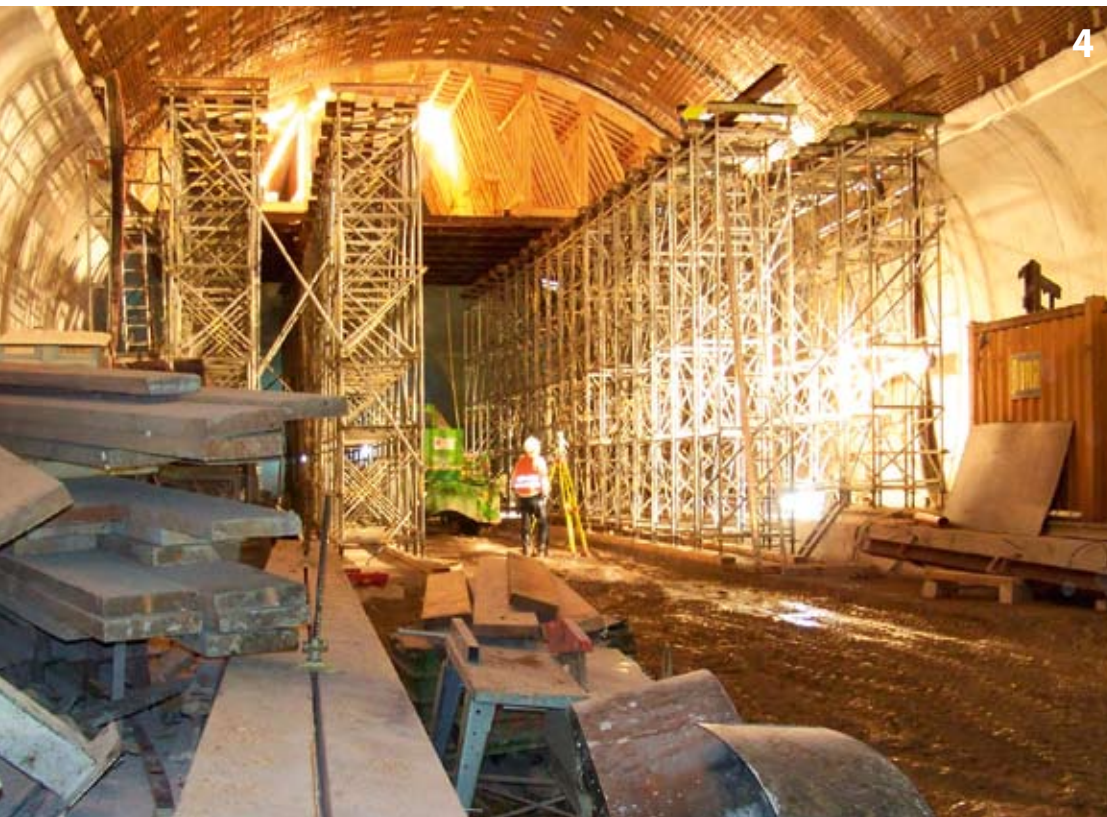
Schalung und Rüstung im Pörzbergtunnel Formwork and scaffolding in the Pörzberg Tunnel
