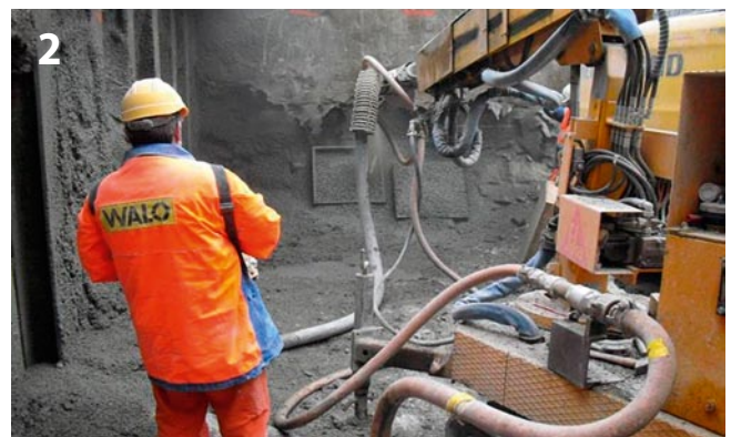
Herstellung eines Prüfkörpers aus Stahlfaserspritzbeton (im Hintergrund sind die Schalungsformen erkennbar)
