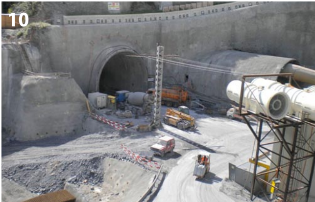
10 Nord- und Südröhre des Eyholz-Tunnels North and south bores of the Eyholz Tunnel
