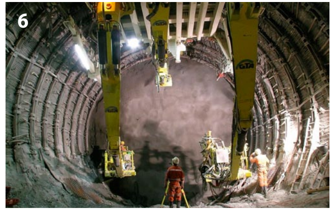
Ortsbrustsicherung mit Dramix® Stahlfaserspritzbeton Securing the face with Dramix® steel fibre shotcrete
