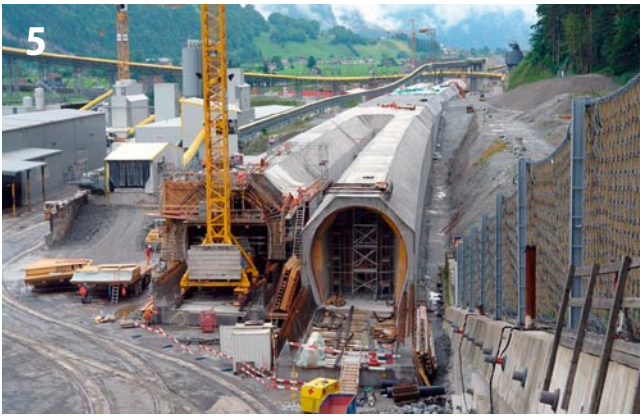
Tagbautunnel Erstfeld, Brandschutzbeton Duomix® M6 Erstfeld cut-and-cover tunnel: fire protection concrete Dramix® M6
