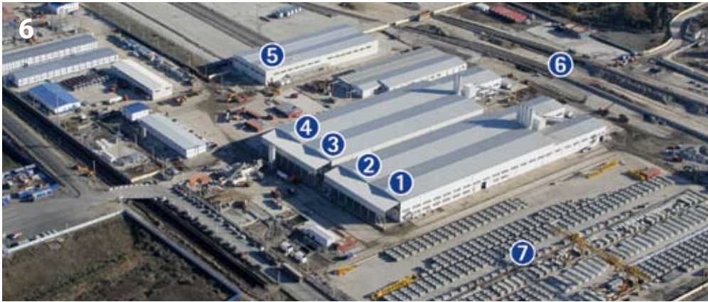
Tübbingproduktionsanlage zur Versorgung von 4 TBM: (1) – (4) Produktionslinien 1-4, (5) Bewehrungskorbproduktion, (6) Betonlager, (7) Tübbinglager
