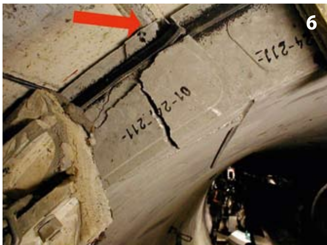
Abplatzung bei Kontakt Tübbing - Schildschwanz
