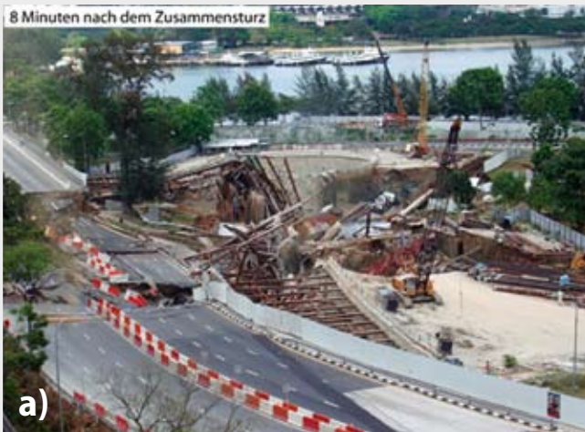
Nicoll Highway Collapse (Circle Line/Singapur, 20. April 2004; COI, 2005): a) Baufeld ca. 8 Minuten nach der Havarie und b) aufgenommene Steifenkräfte in der Baugrube. Zu erkennen ist eine signifikante Entwicklung der Steifenkräfte bereits 4 h vor Eintritt der Havarie
