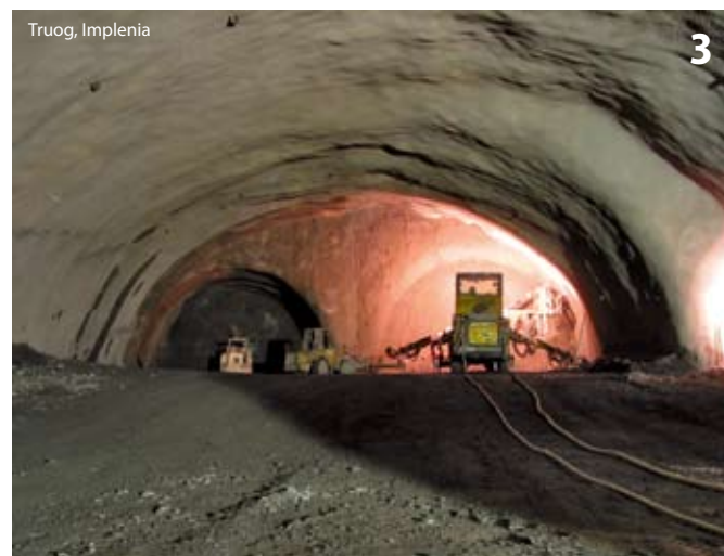
Abdichtungsträger im Bereich der Aufweitung
