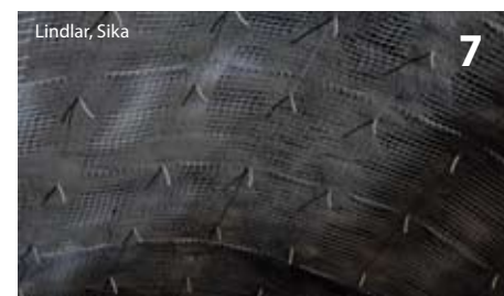
Rasterweises Einspritzen der Rückprallreduktionsmaßnahme
