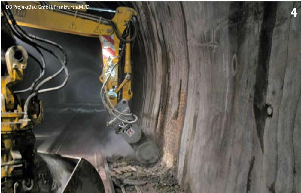
Abschrämen des alten Mauerwerks mit einer Fräse
