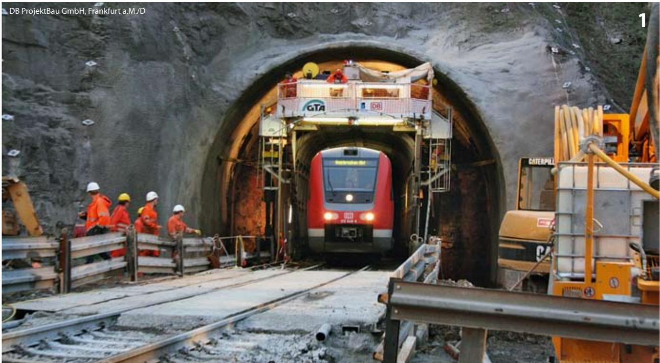
Jährder Tunnel während der Aufweitung mit der Tunnel-im-Tunnel Methode
