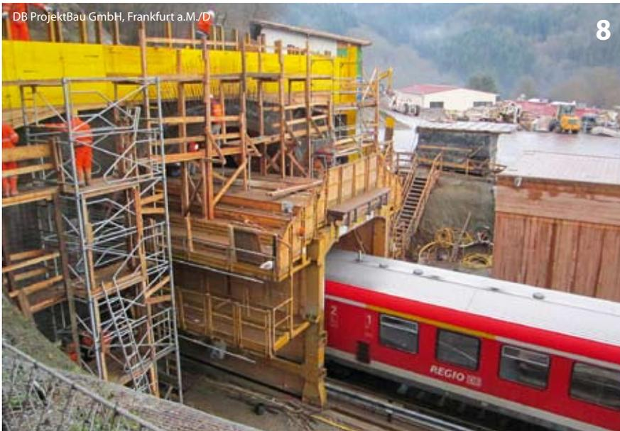
Schalwagen bei der Betonage des Portalblocks und der Portalscheibe am Frauenberger Tunnel
