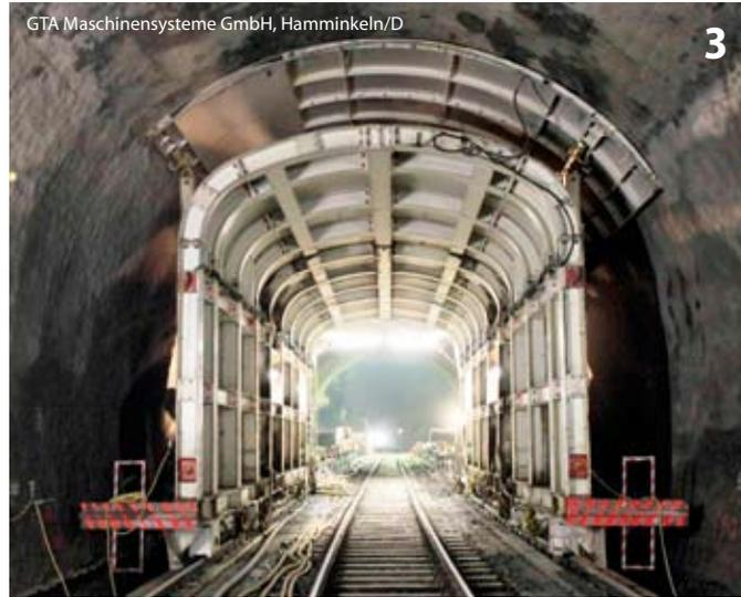
Stützplatten in der Firste zur Vorbruchsicherung
