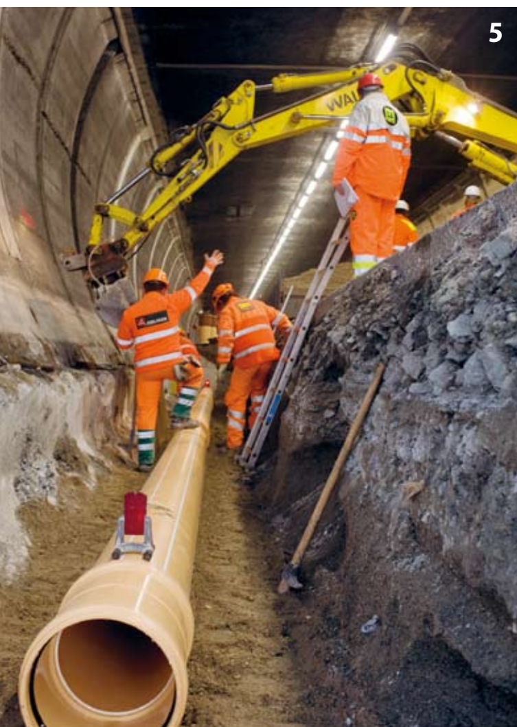
Entwässerungsleitungen Drainage lines
