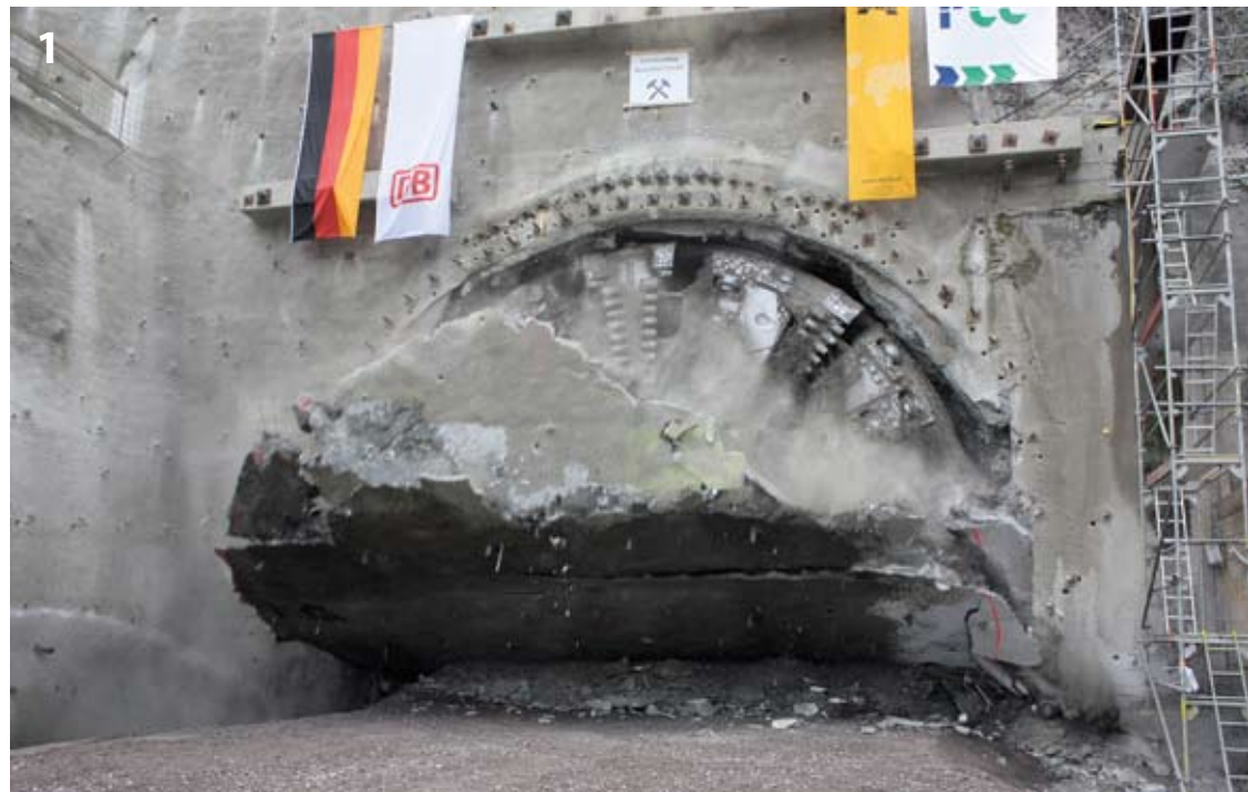
Durchschlag TVM Portal Cochem
