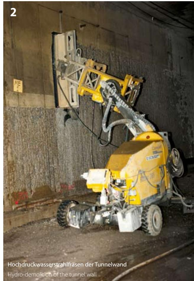
Hochdruckwasserstrahlfräsen der Tunnelwand
