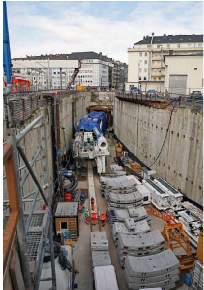
Im Startschacht werden die 6,6 t schweren Tübbinge auf den Tunnelzug geladen, der diese just in time direkt zur Einbaustelle transportiert
