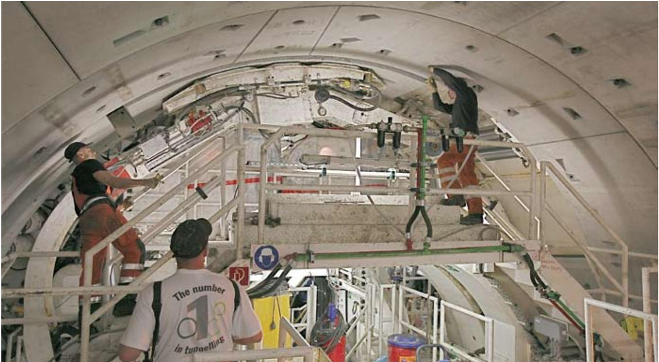
Tübbing-Montage im Tunnelfirst: Die 7+1 Elemente ergaben einen 46,2 t schweren Ring
