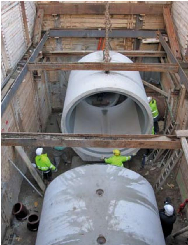
Direkt neben der neuen U-Bahn-Trasse musste ein 4 km langes, weitläufiges Kanalnetz aus Hochleistungs-Stahlbetonrohren verlegt werden, oft unmittelbar entlang der Häuserfronten
