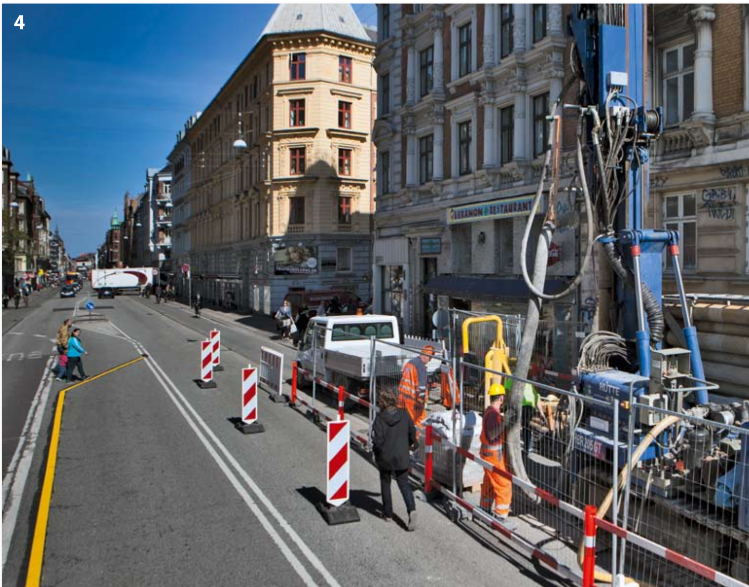
Brunnenbohrarbeiten im öffentlichen Straßengebiet an der Metrostation "Nuuka Plada"
