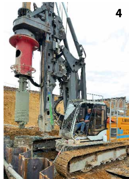
Herstellung der Brunnenbohrung Drilling of wells
