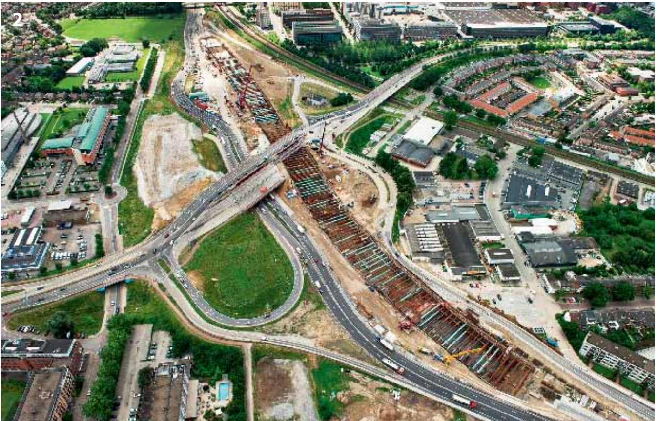
Luftbild auf einen Teil der ausgesteiften Baugrube Aerial shot of a part of the braced excavation pit
