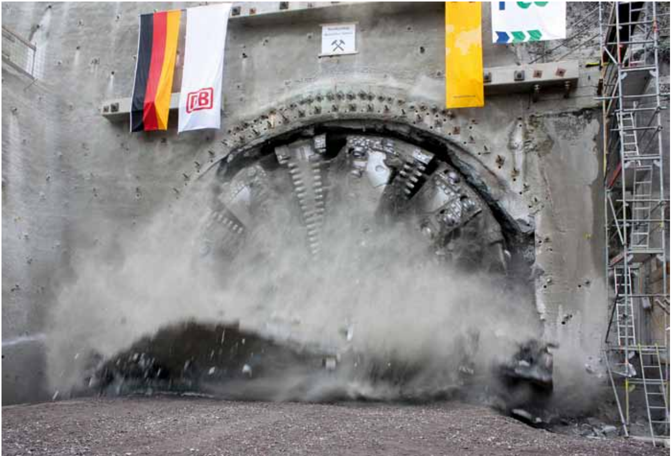
Tunneldurchschlag am 7. November 2011
