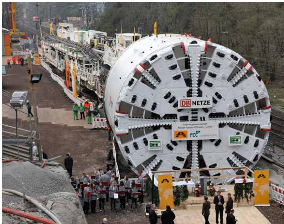
Tunnelvortriebsmaschine bei der Andrehfeier am 10. April 2010
