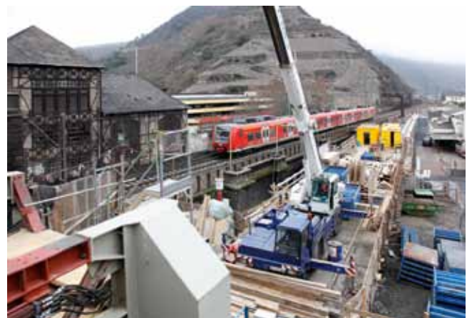
Endphase Bau der Eisenbahnüberführung Brückenstraße Cochem
