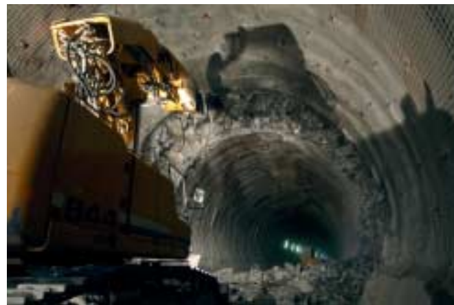
19 Nachprofilierung im Lucomagno-Gneiss
