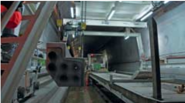
21 Verlegen der Bankett-Fertigelemente
