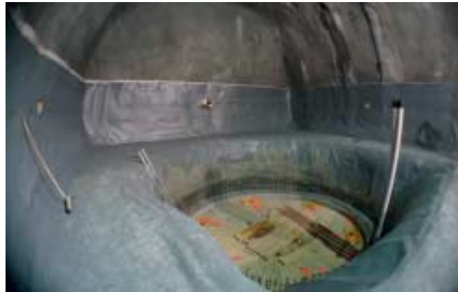
18 Innenausbau der Abluftschächte in der MFS Faido
