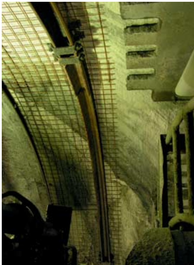
17 Ausbruchssicherung während der Durchquerung der Piora-Mulde
