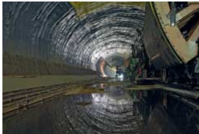
4 Innenausbau der Tunnelverzweigung in der Multifunktionsstelle Sedrun
