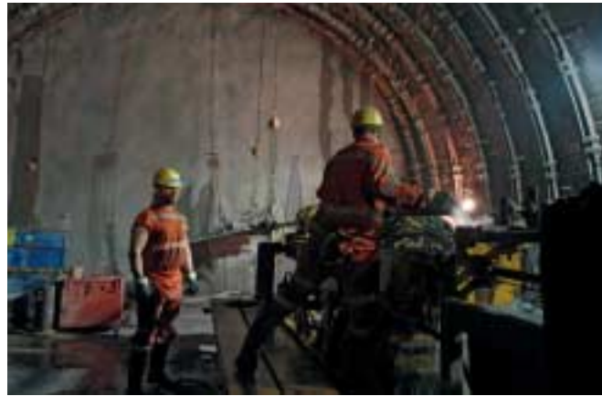
14 Vorauserkundung mittels Schlagbohrung im Teilabschnitt Sedrun
