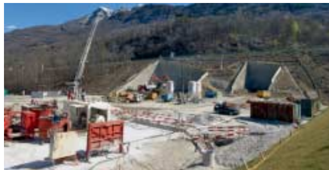
5 Unterquerung der Autobahn A2 in Vigana, Voreinschnitt
