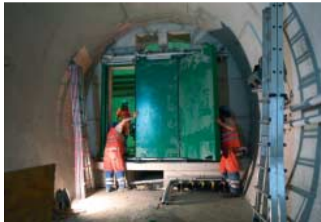
3 Einbau der Querschlagstüren im Abschnitt Amsteg
