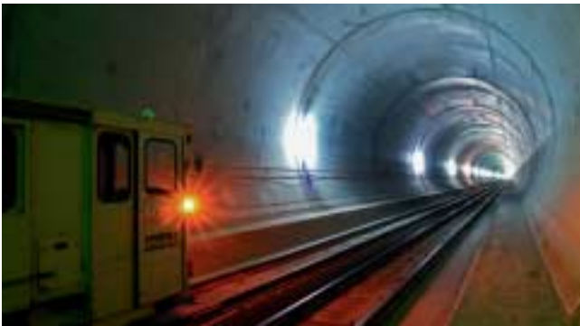
22 Tunnel mit fertig gestelltem Innenausbau
