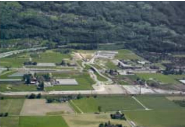
3 Luftaufnahme der Baustelle Camorino
