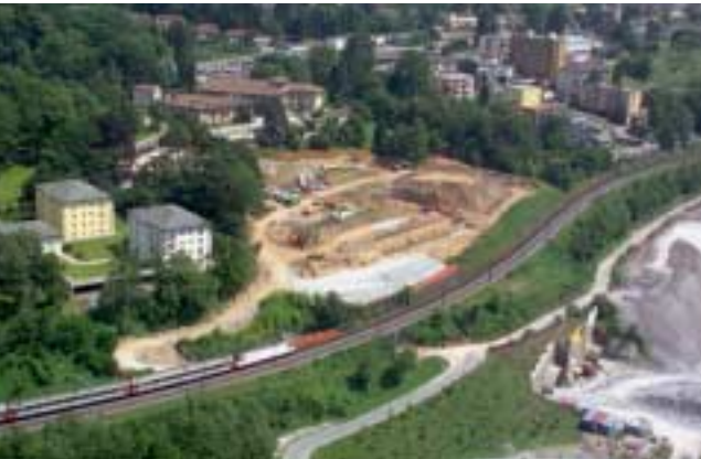
4 Luftaufnahme der Baustelle Vezia
