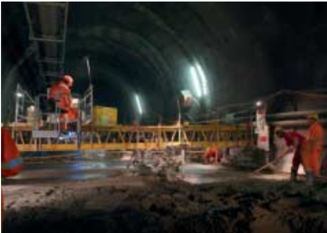
7 Einbau der Fahrbahnplatte im Zugangstollen
