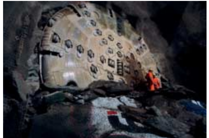
8 Durchschlag des Fensterstollens am 6. November 2008
