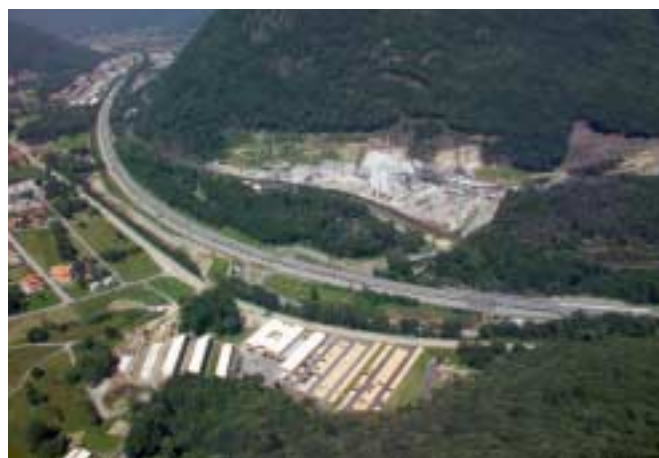
2 Luftaufnahme der Baustelle Sigirino
