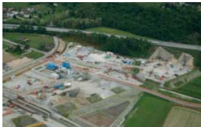
10 Luftaufnahme mit gut sichtbaren Vorbelastungsschüttungen
