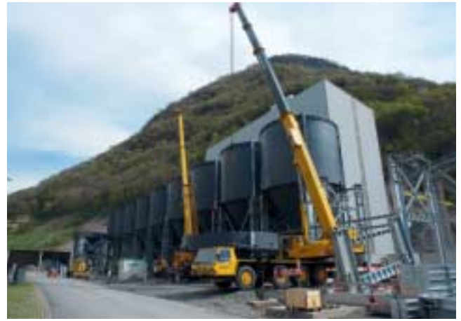
6 Installation der Silos für Betonzuschlagstoffe
